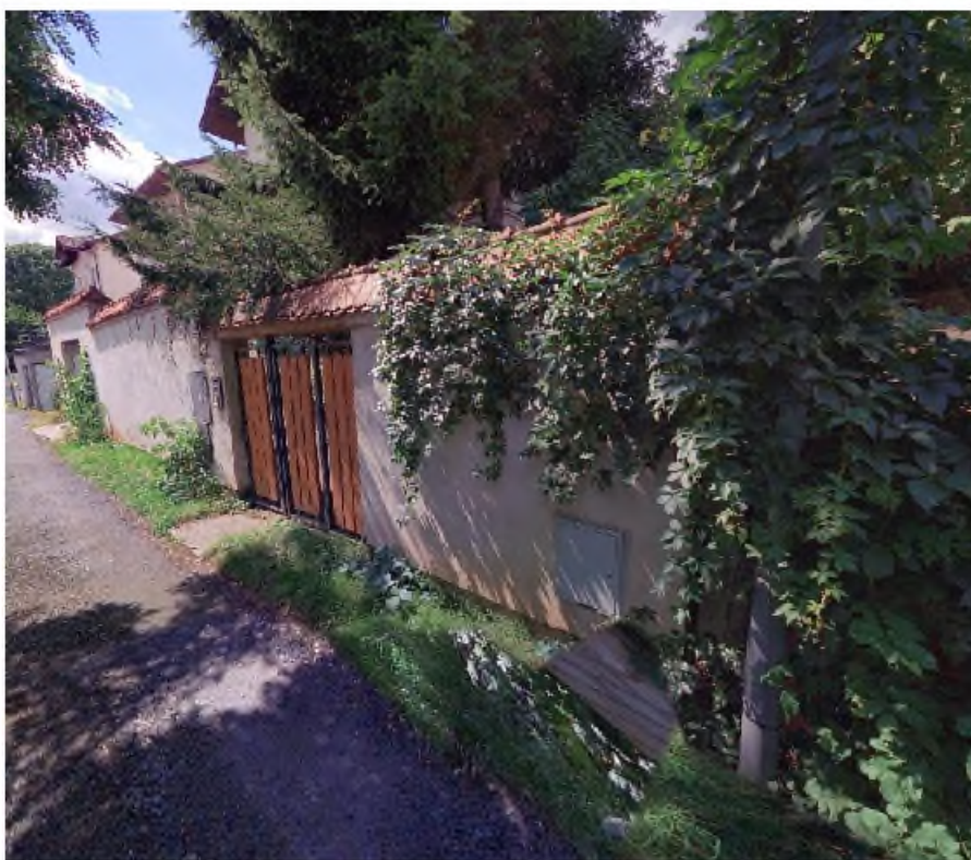
Oplocení realizované současně se stavbou garáže u domu č.p. 153. Vodoměrná šachta je součástí oplocení.
