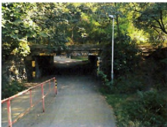
Podchod pro pěší pod výtaznou kolejí, umístěnou podél železniční tratě
