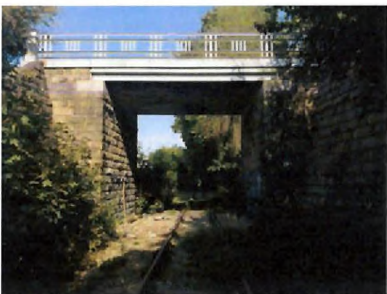
Lávka pro pěší u východní hranice pozemku parc.č. 4449
