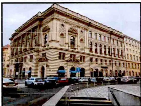
pohled do ulice Korunní
