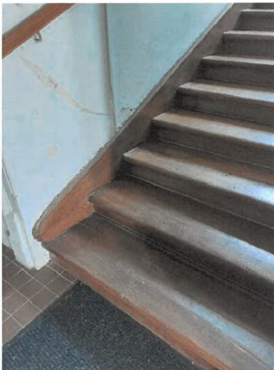
Foto 10 – Interiéry – dřevěné schodiště bez známek degradace – doporučená pravidelná údržba a revize
