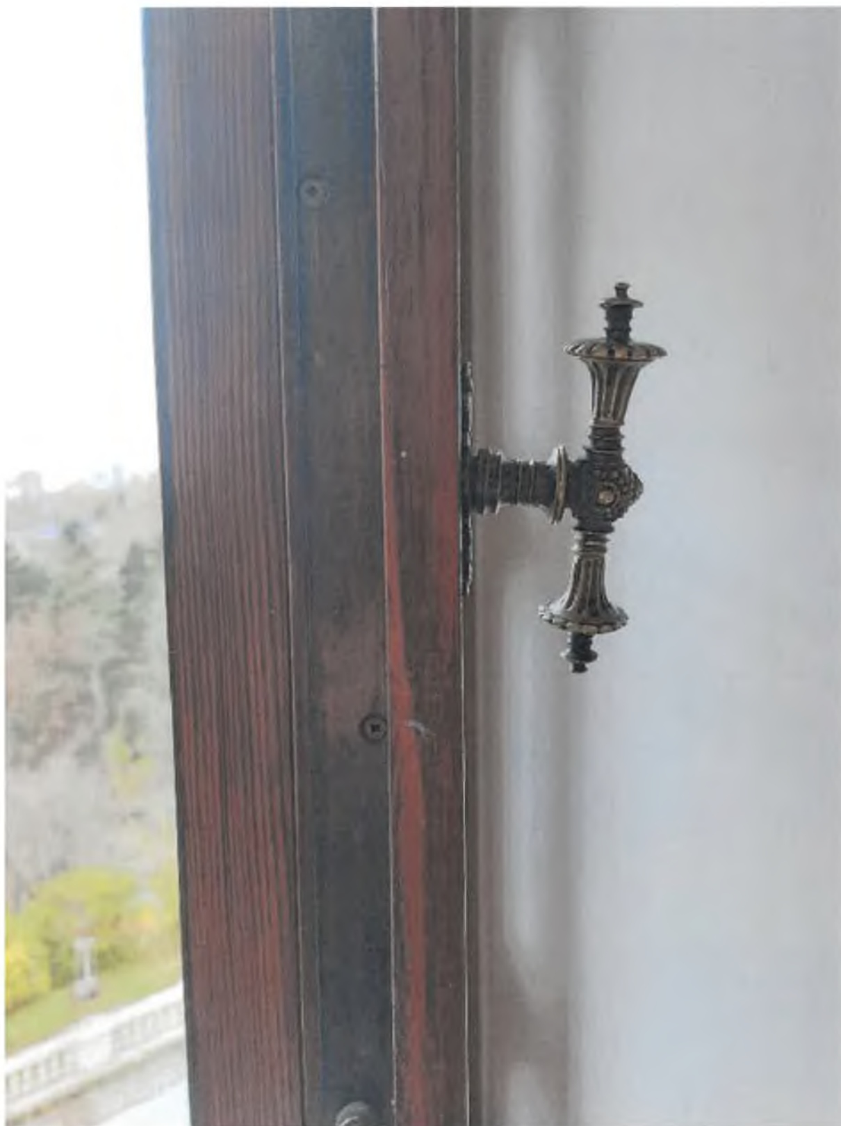
Foto 51 – Interiér – Zdobné kování oken
