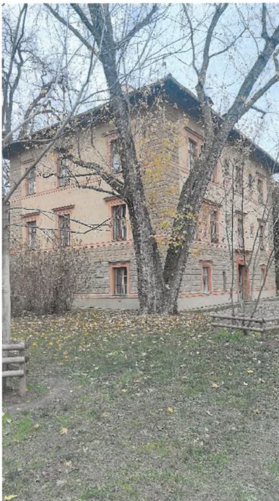
Foto 2 – Fasáda - západní fasáda
