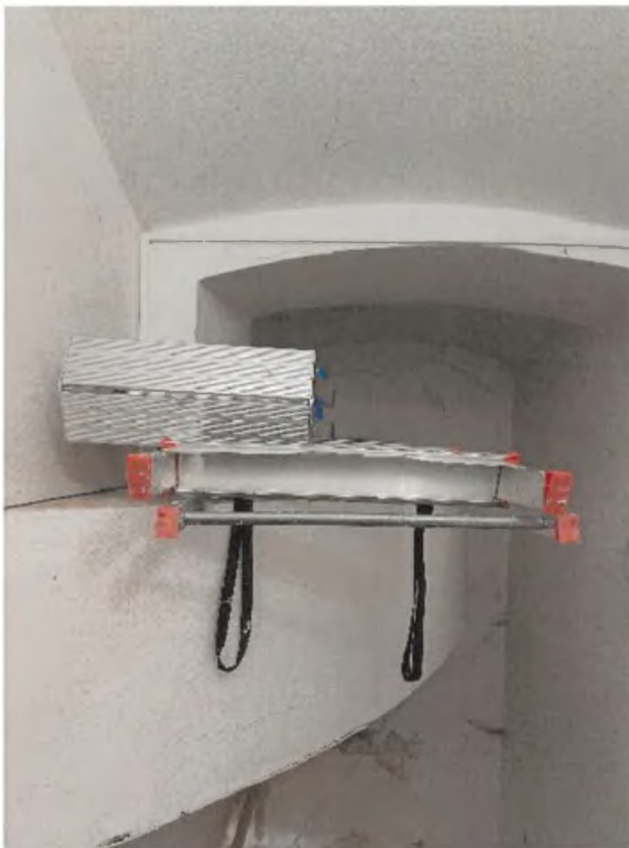
Foto 17 – Interiéry – technická místnost – potrubí VZT
