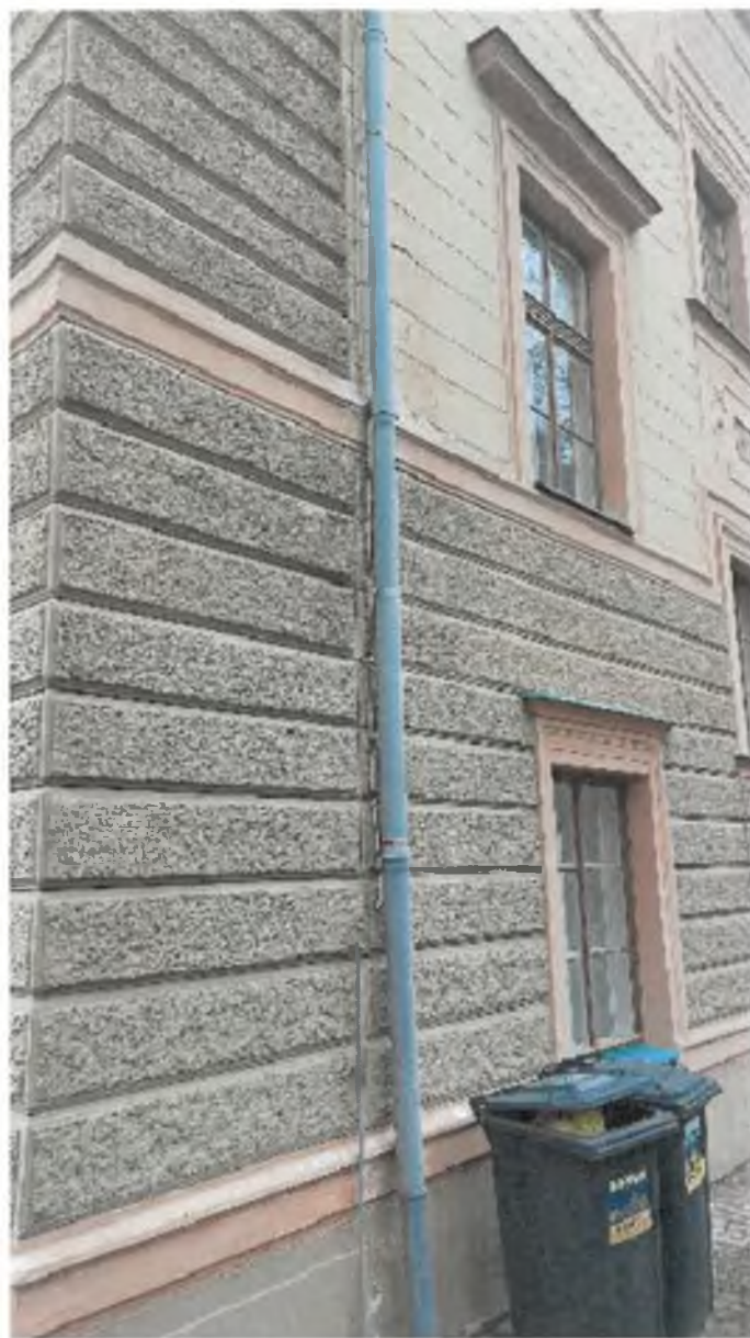
Foto 7 – Výplně otvorů – okna a ostění
