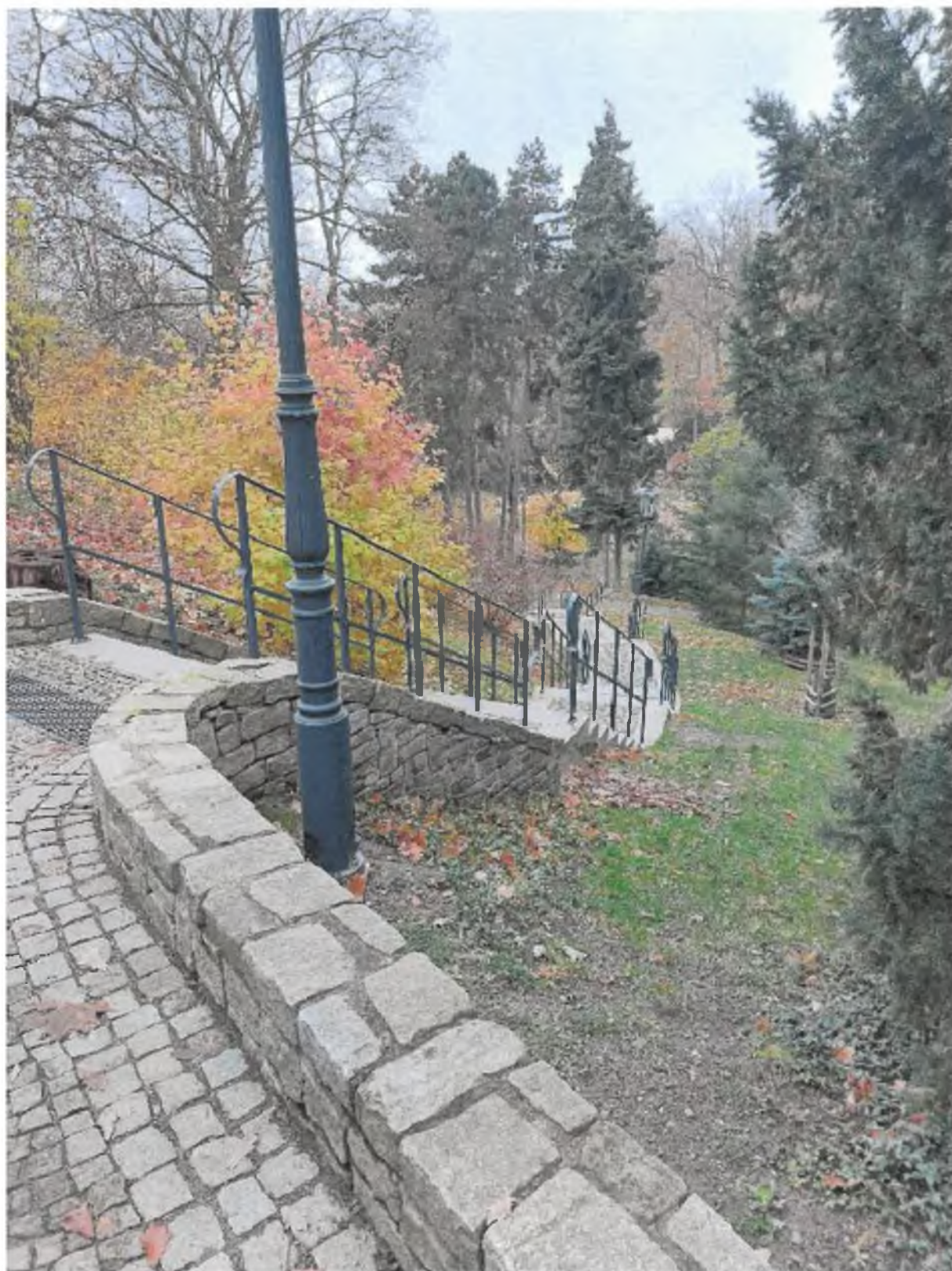
Foto 35 – Venky – Parkové schodiště vyhovující
