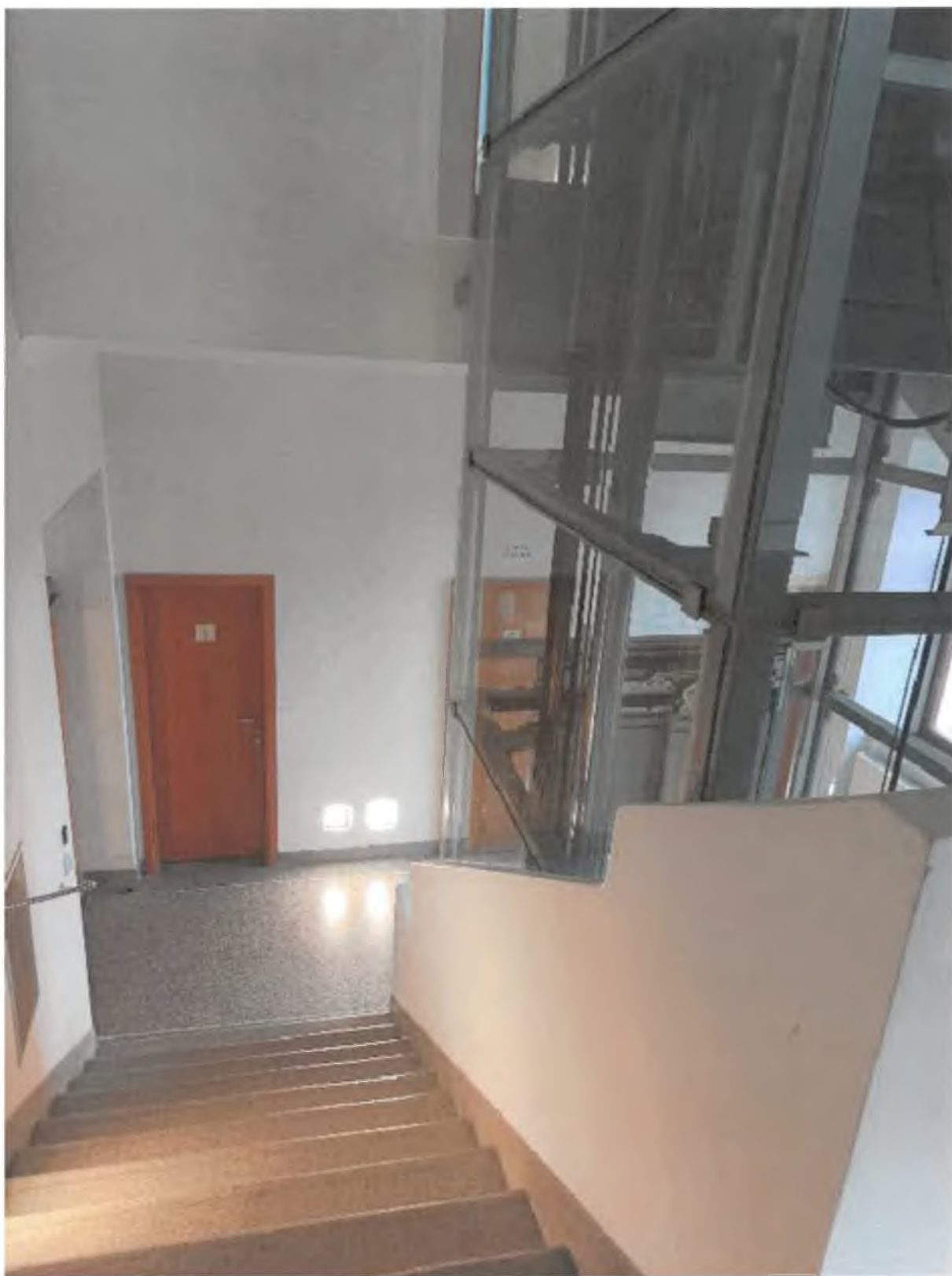
Foto 63 – Interiér – Interiérové povrchy a výtah vyhovující
