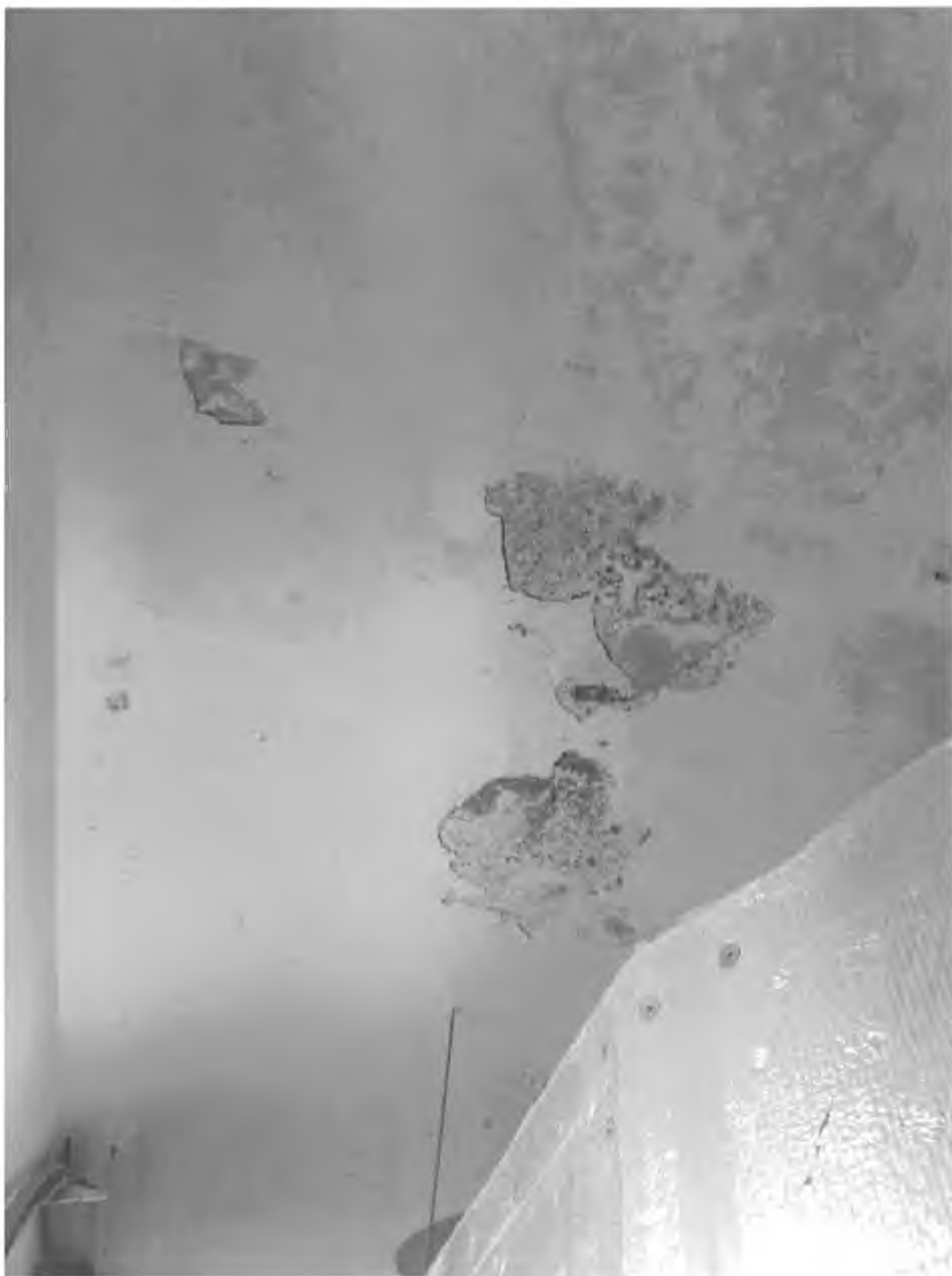
Foto 73 – Interiér – Vlhké sklepy – doporučeno řešit větrání + Chladicí jednotka (chiller) TRANE 3-D Scroll, určená k výrobě chladu pro vodní okruh (např. fan coils, VZT chladiče, klimatizaci serverovny nebo objektu)
