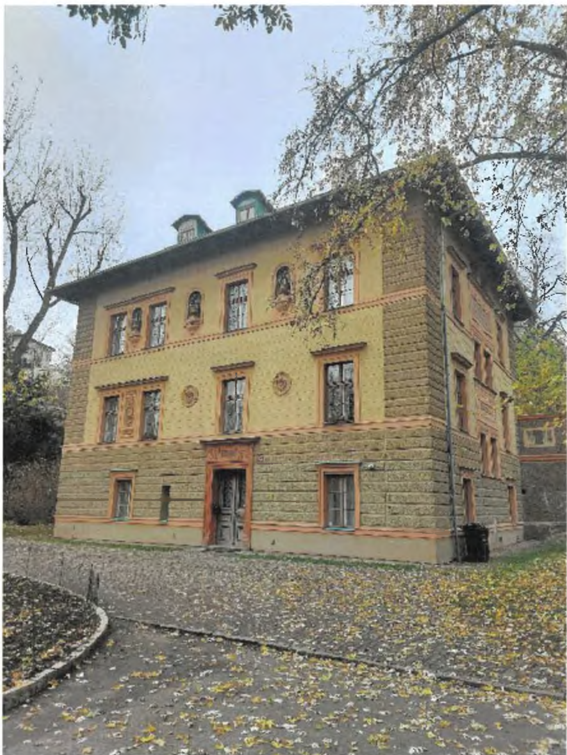
Foto 1 – Fasáda - jižní fasáda - hlavní průčelí
