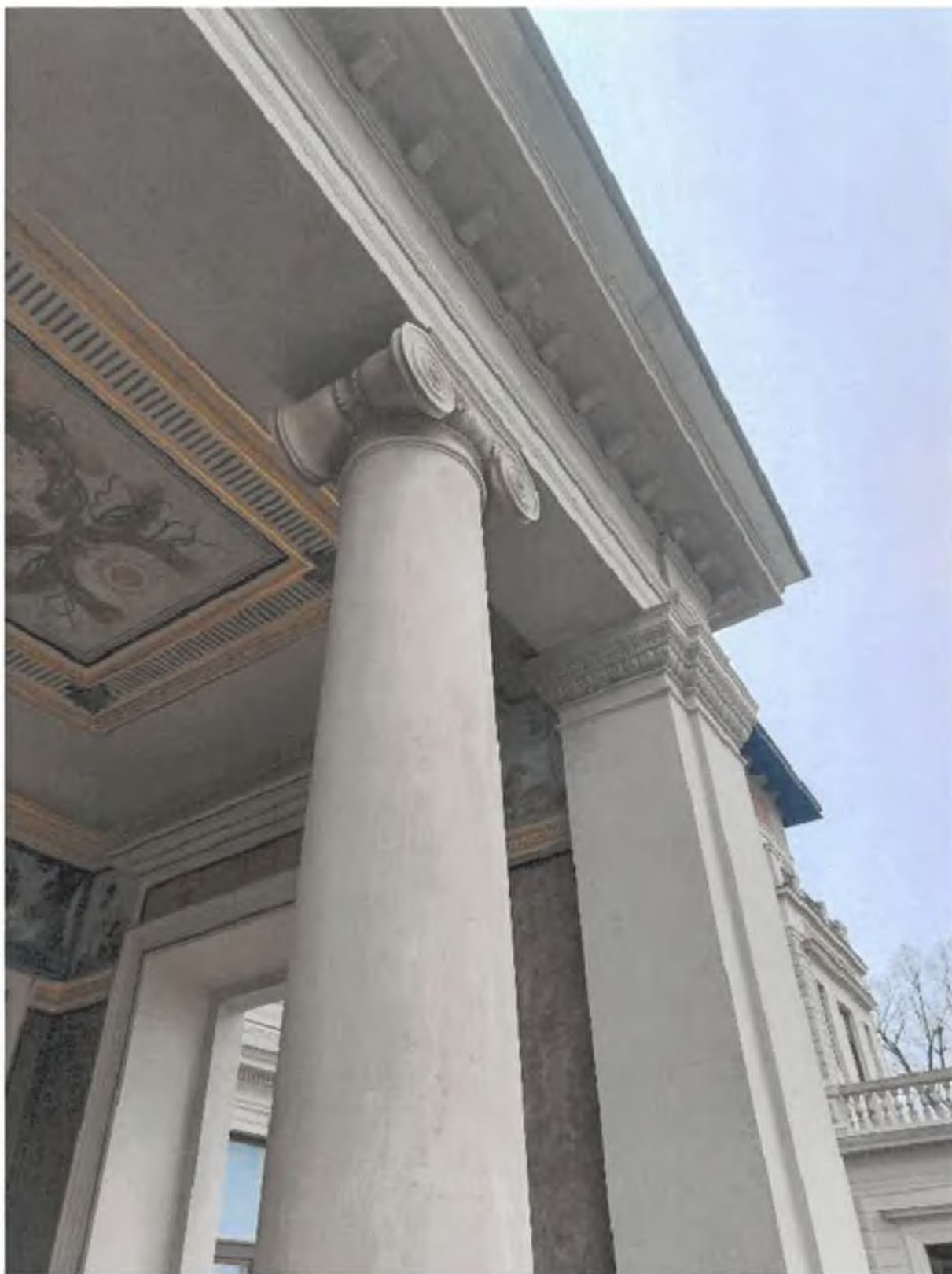
Foto 21 – Fasáda – jižní fasáda – zdobné prvky fasády – malované stropy - římsy
