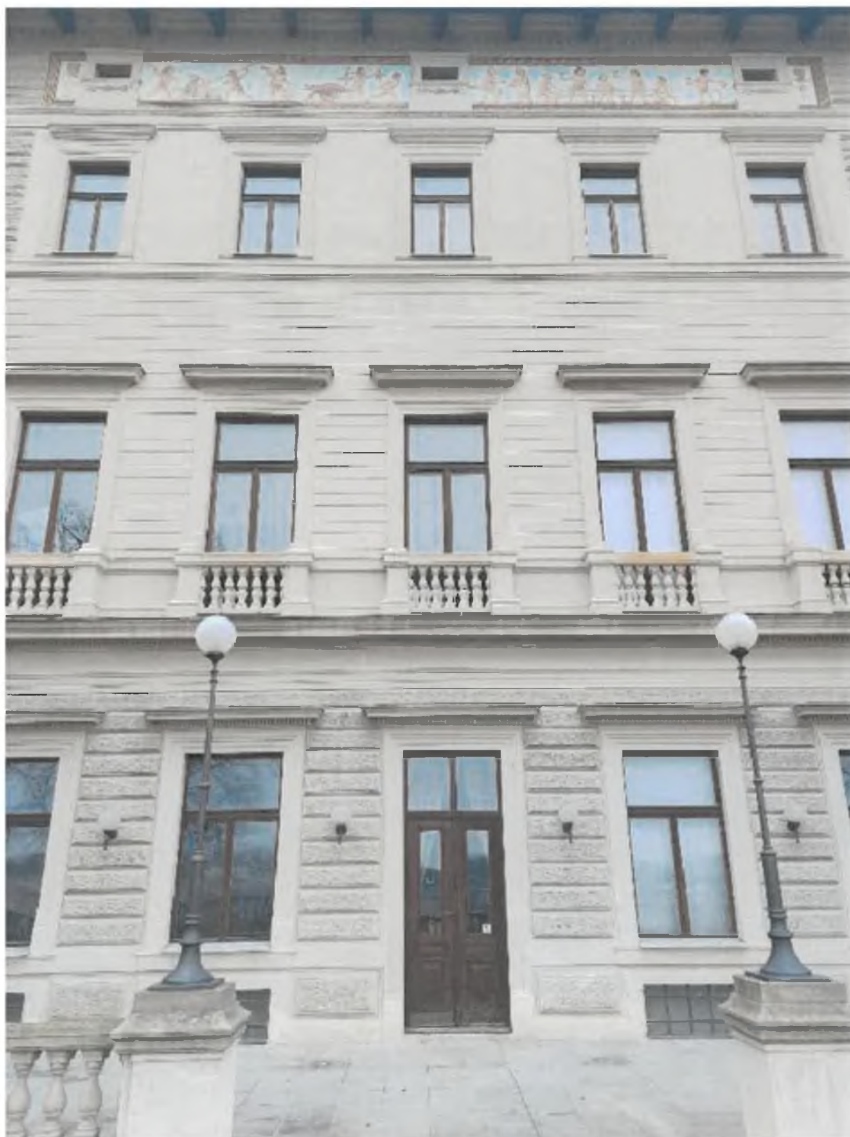
Foto 11 – Fasáda – jižní fasáda
