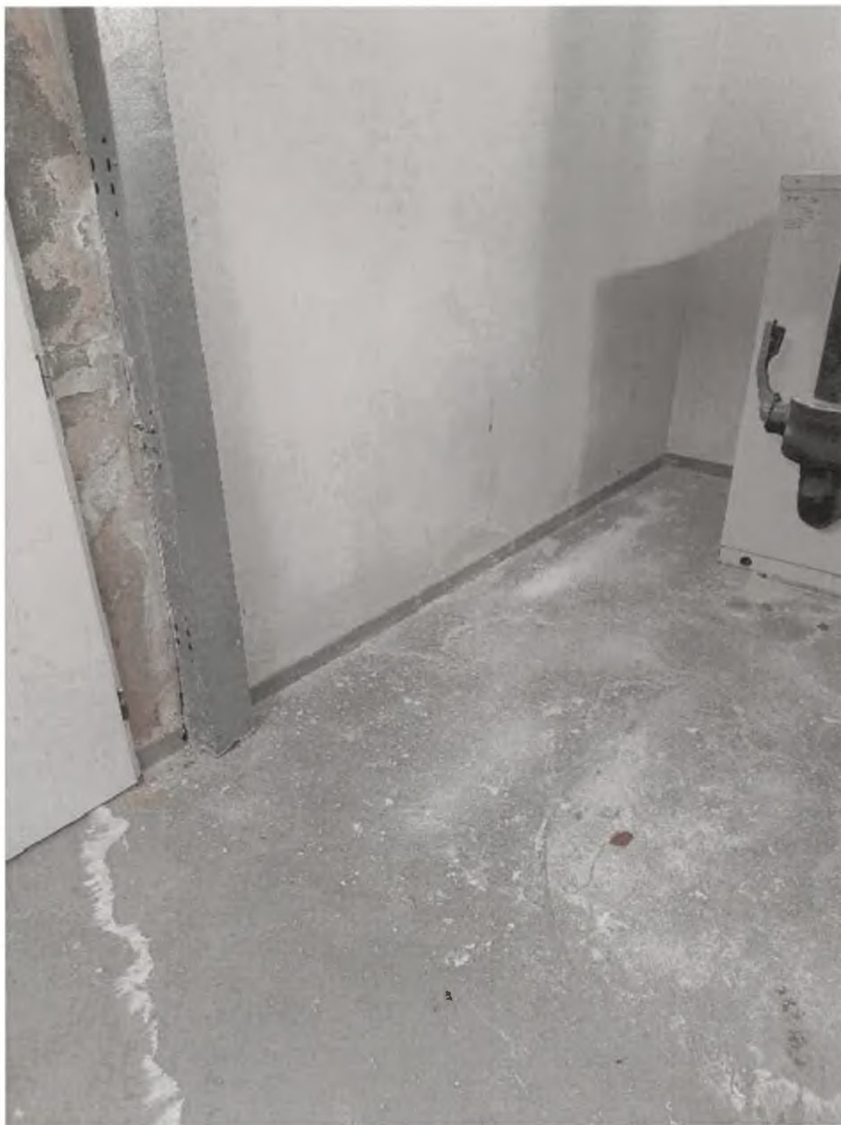
Foto 45 – Interiér – Vlhkost v 1.PP
