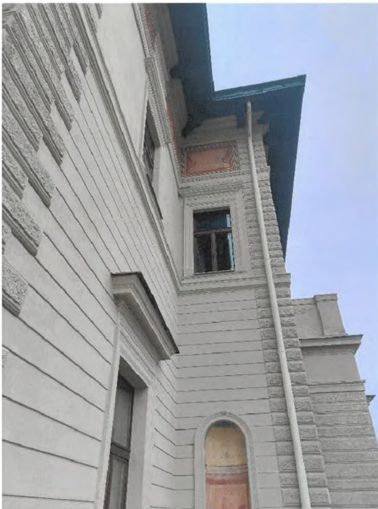
Foto 8 – Fasáda – jižní fasáda
