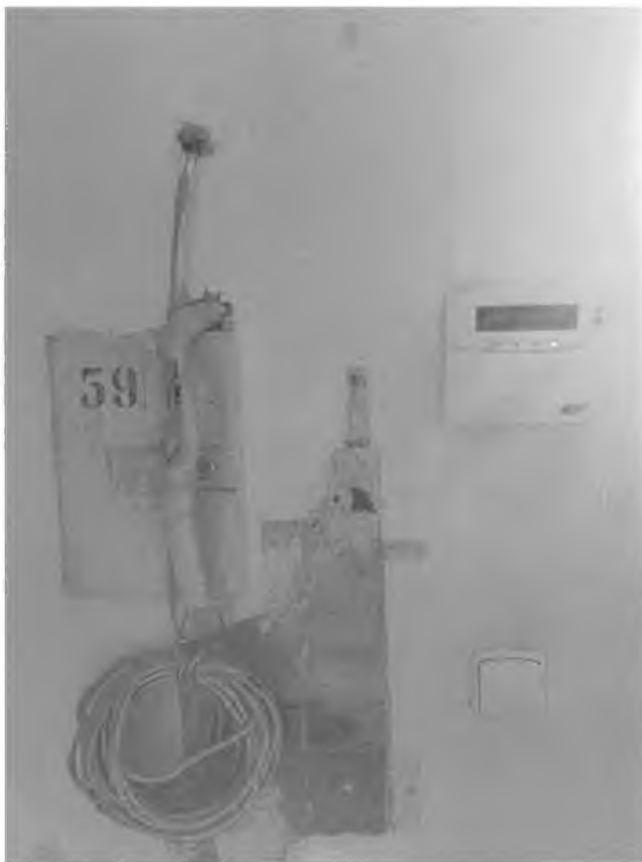
Foto 13 – Interiéry – stratigrafický průzkum malířských vrstev na chodbě
