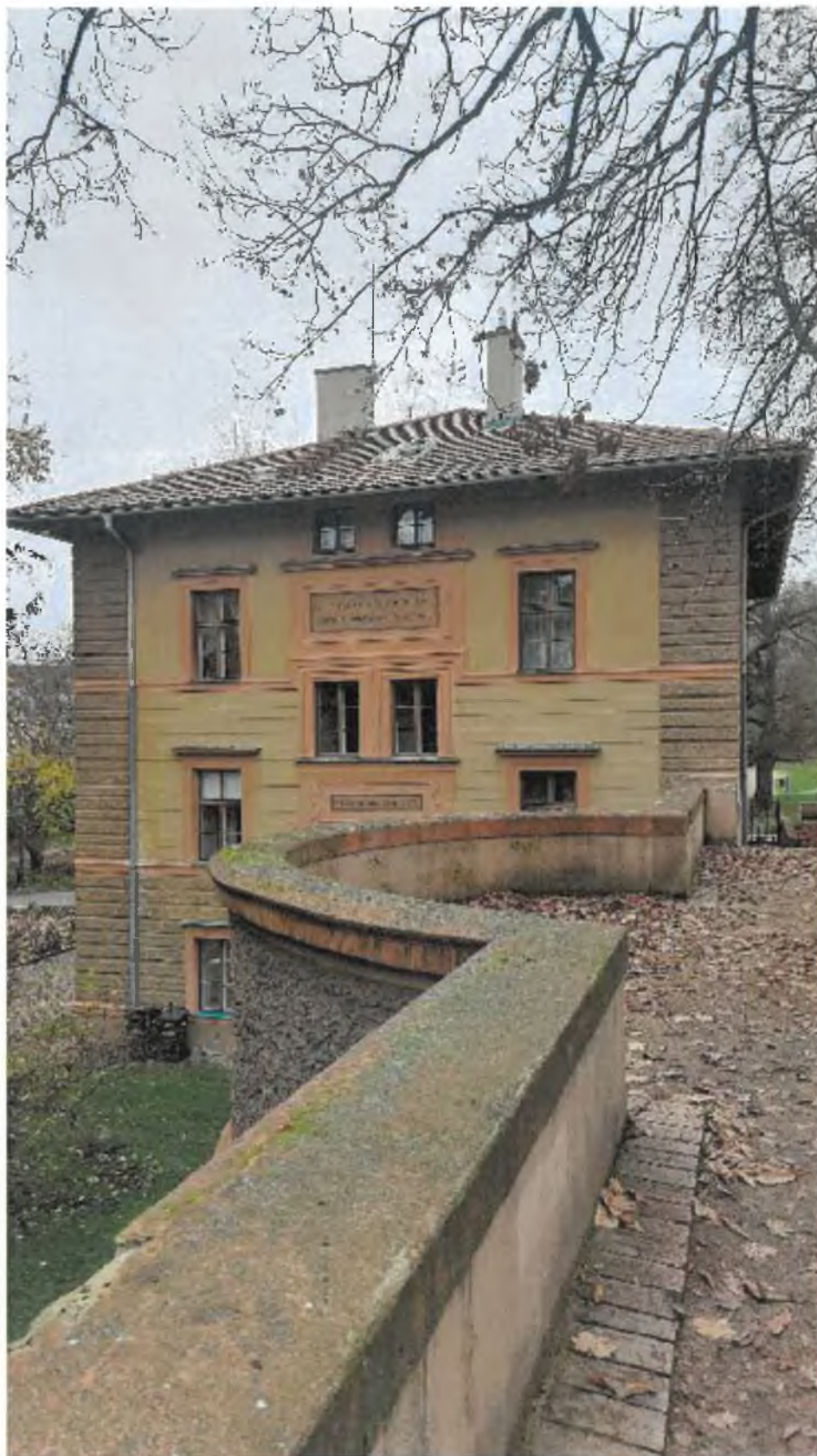
Foto 3 – Fasáda - východní fasáda
