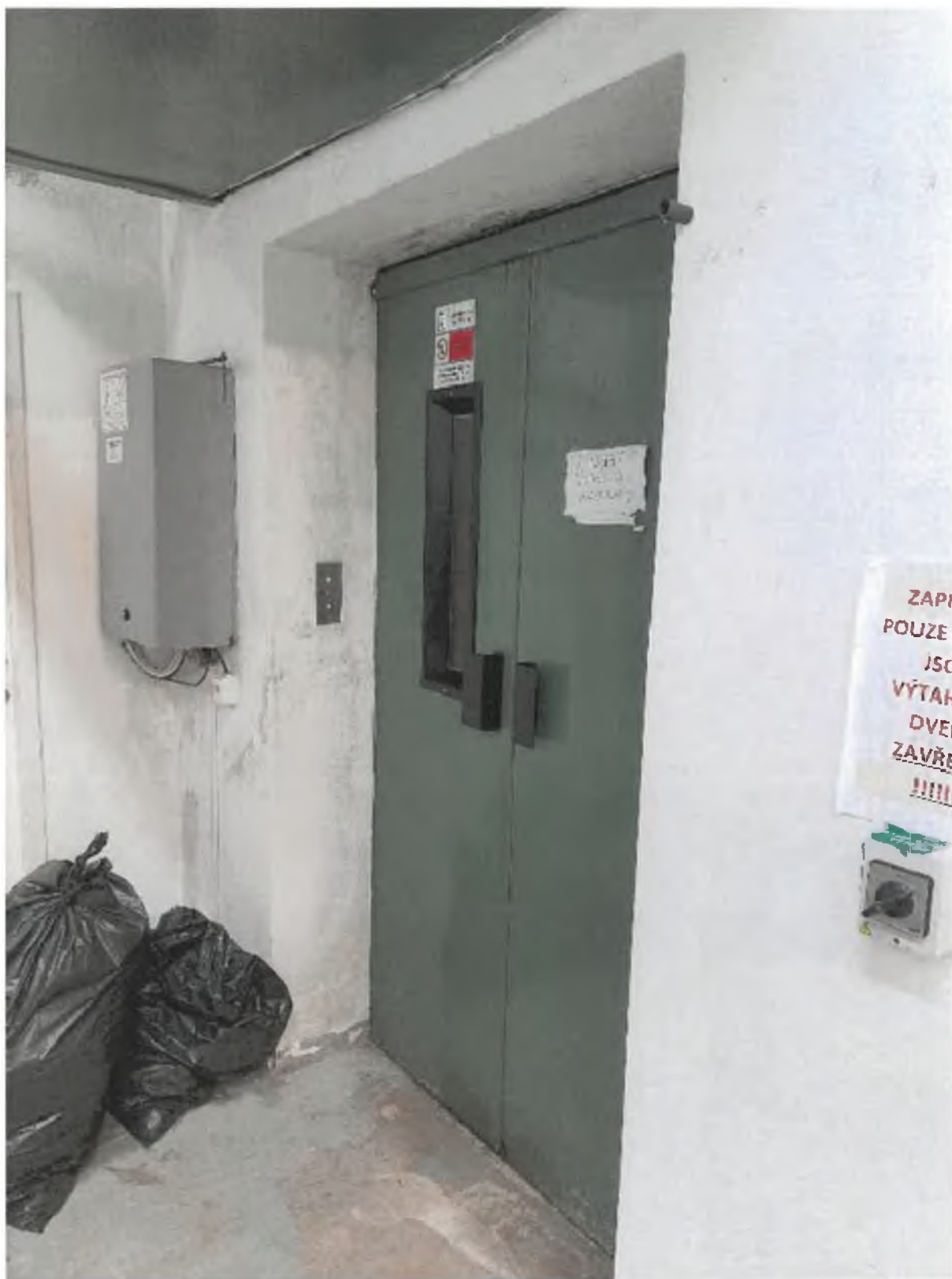
Foto 80 – Interiér – nákladní výtah
