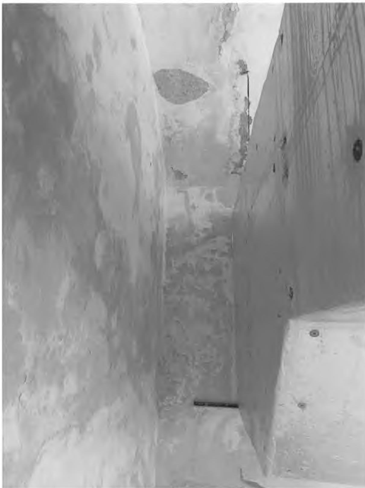
Foto 75 – Interiér – Vlhké sklepy – doporučeno řešit větrání + Chladicí jednotka (chiller) TRANE 3-D Scroll, určená k výrobě chladu pro vodní okruh (např. fan coils, VZT chladiče, klimatizaci serverovny nebo objektu)
