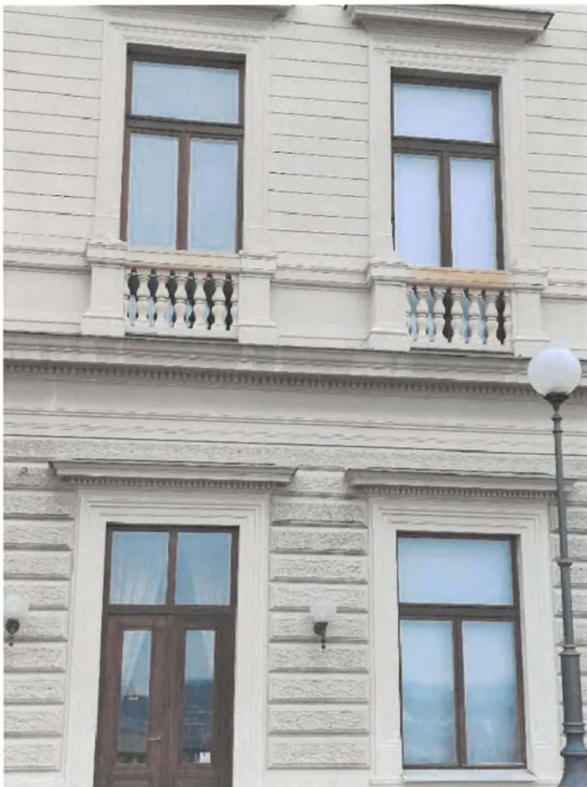
Foto 12 – Fasáda – jižní fasáda
