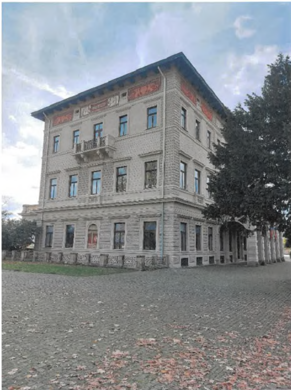
Foto 1 – Fasáda – severovýchodní roh
