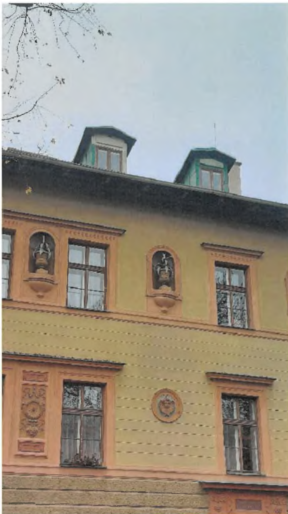
Foto 5 – Výplně otvorů – okna
