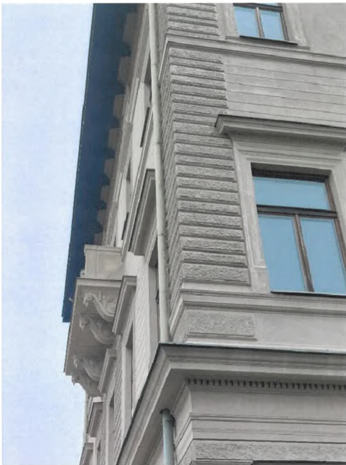
Foto 16 – Fasáda – severovýchodní roh domu
