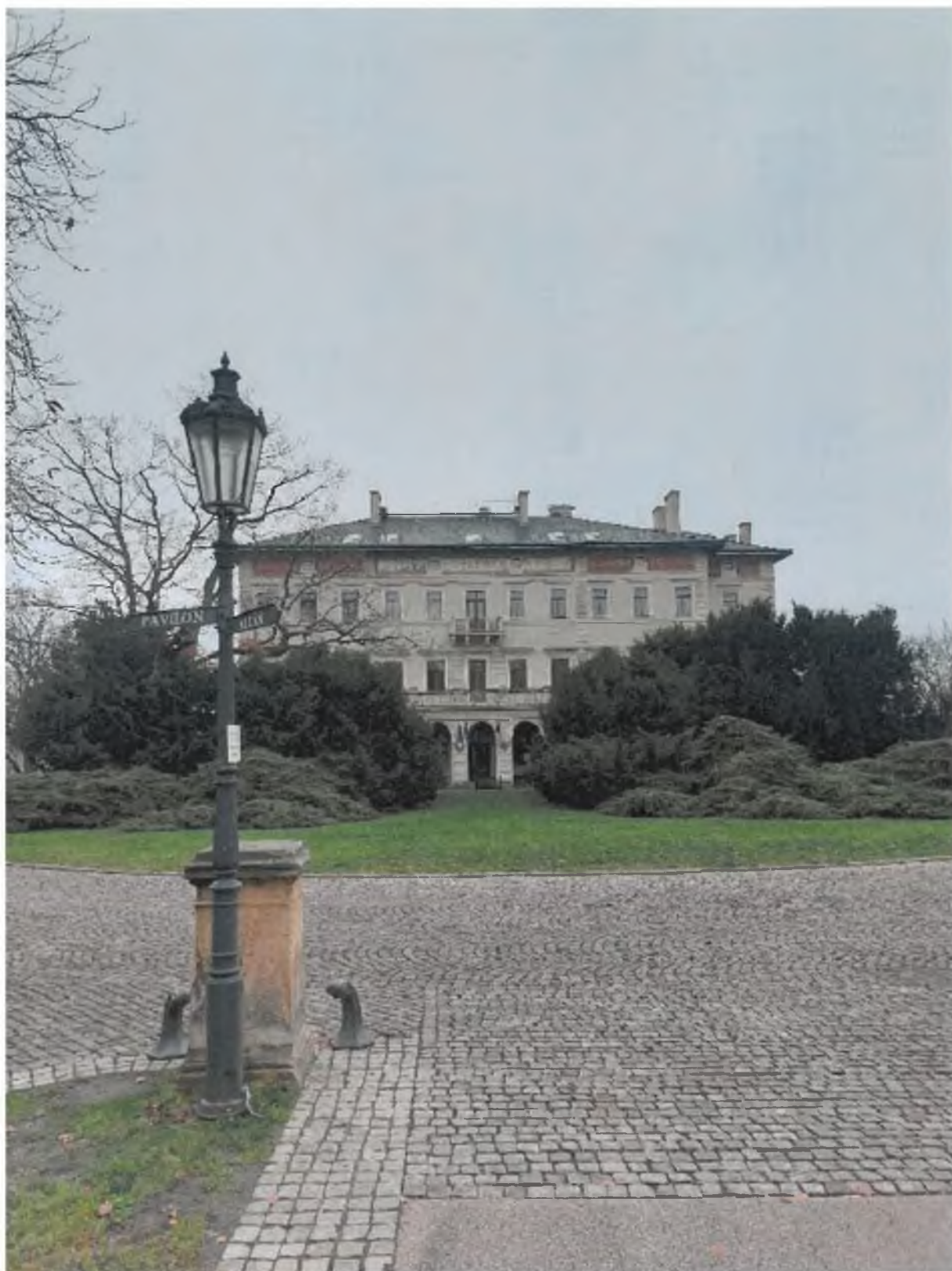
Foto 17 – Fasáda – severní fasáda
