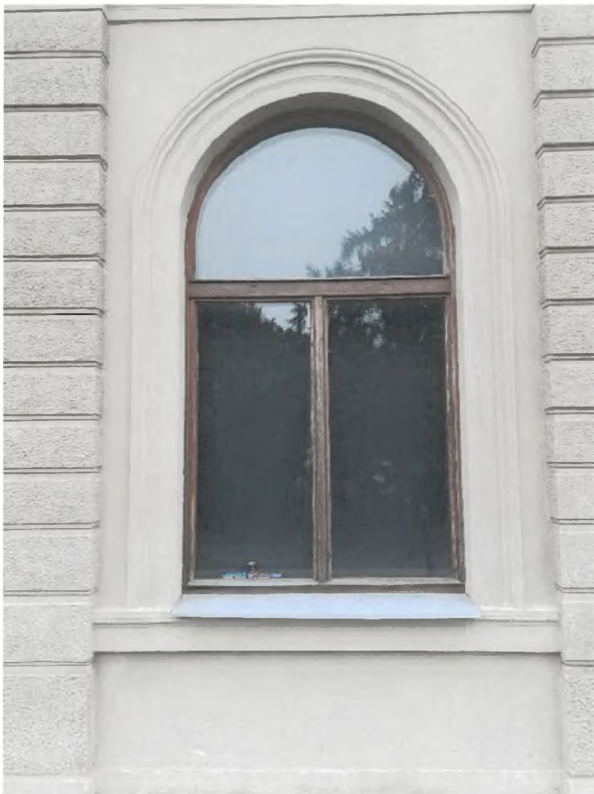
Foto 29 – Výplně otvorů – okno severní fasády 1.NP
