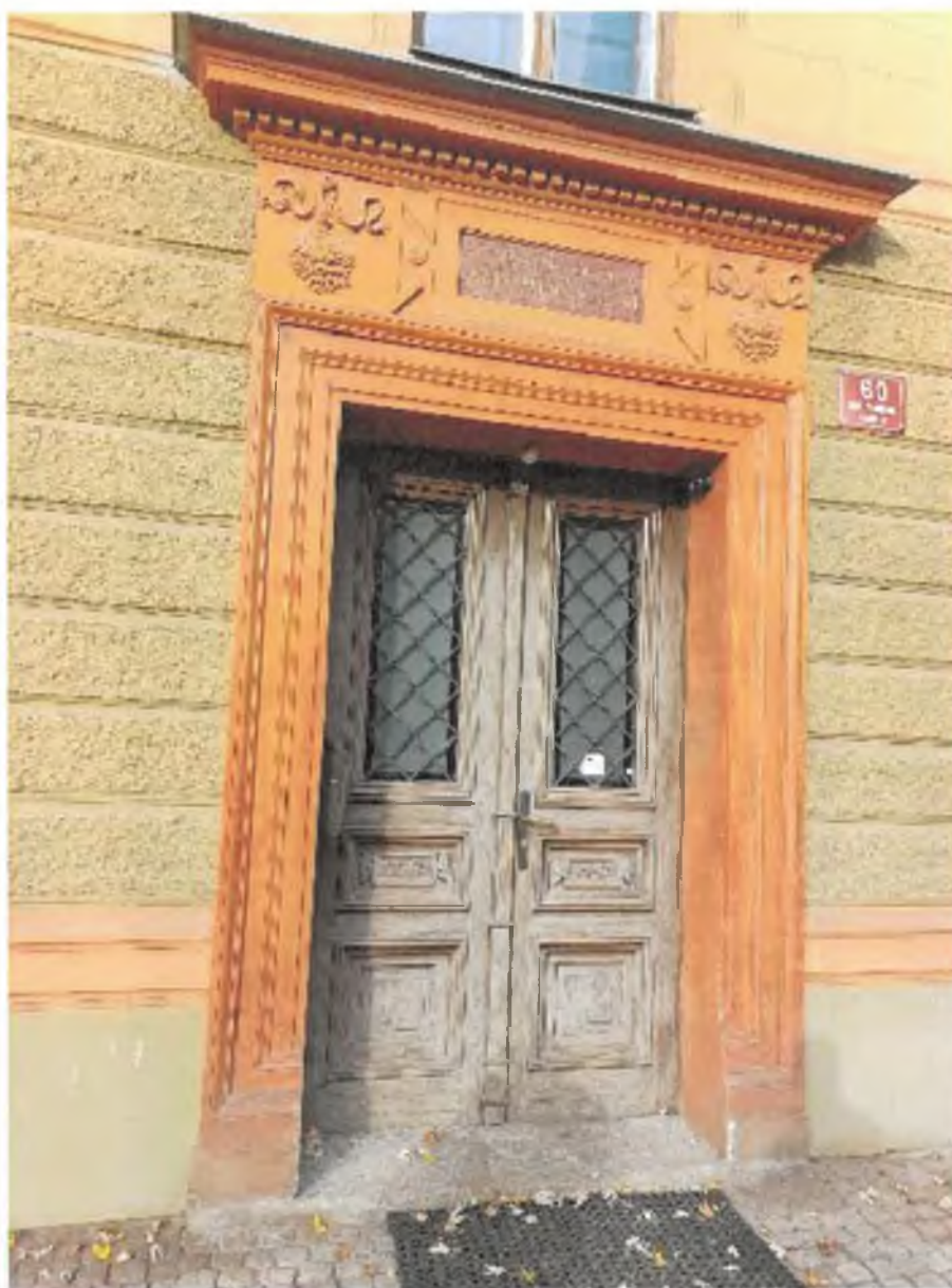
Foto 6 – Výplně otvorů – hlavní dveře
