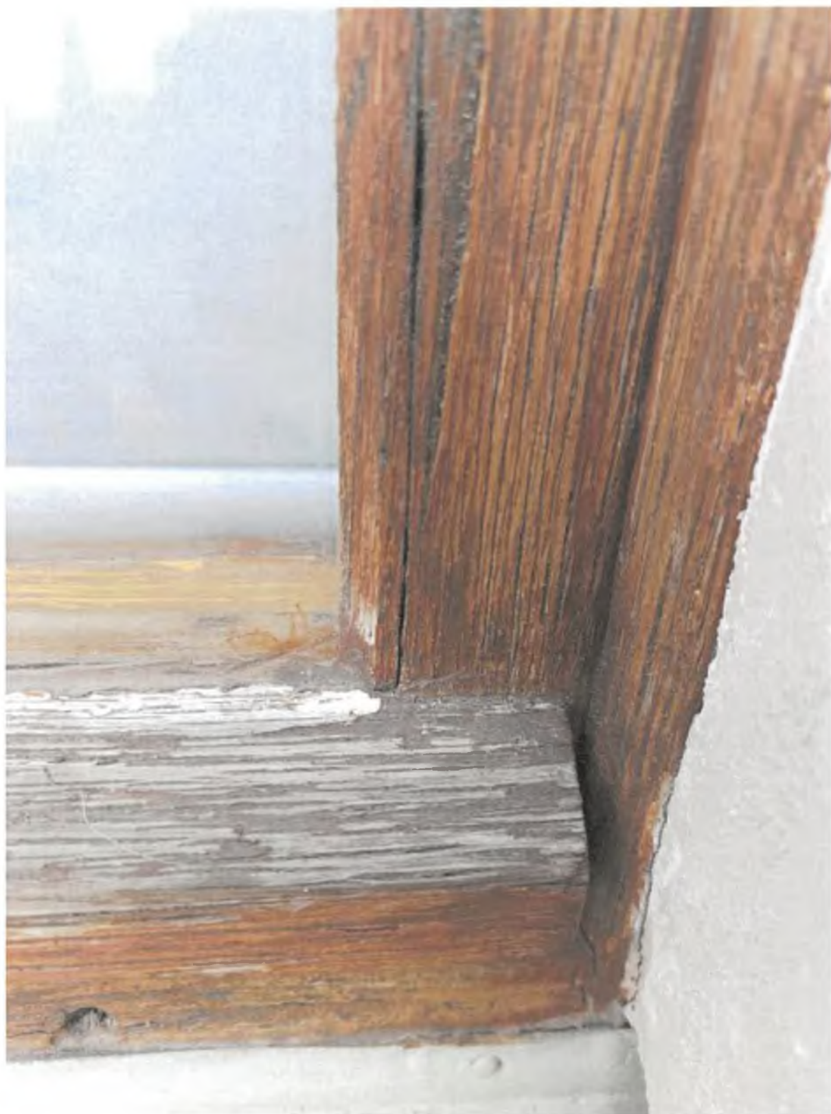
Foto 34 – Výplně otvorů – detail spodního rohu oken
