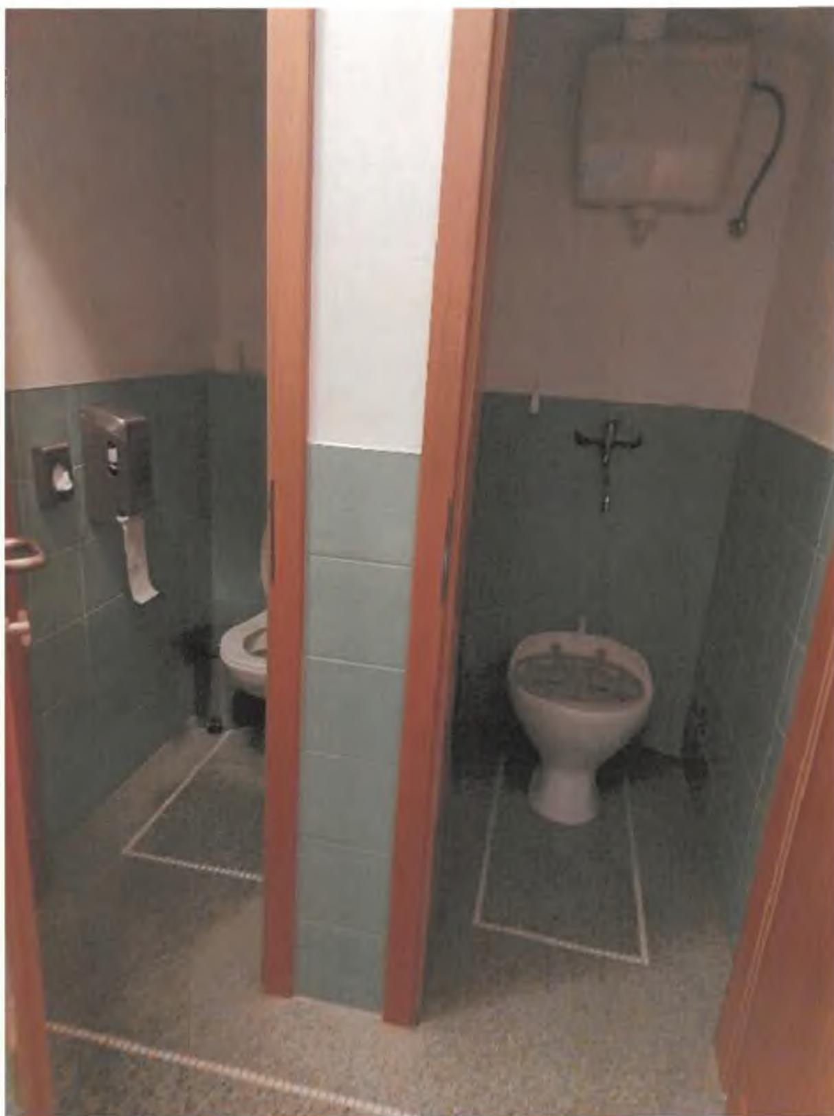
Foto 49 – Interiér – Vyhovující sociální zázemí
