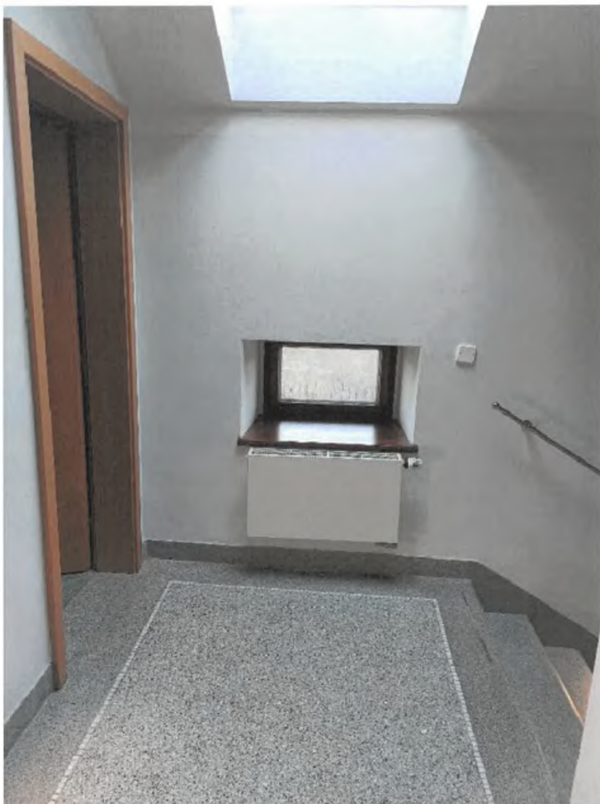
Foto 47 – Interiér – Otopná tělesa
