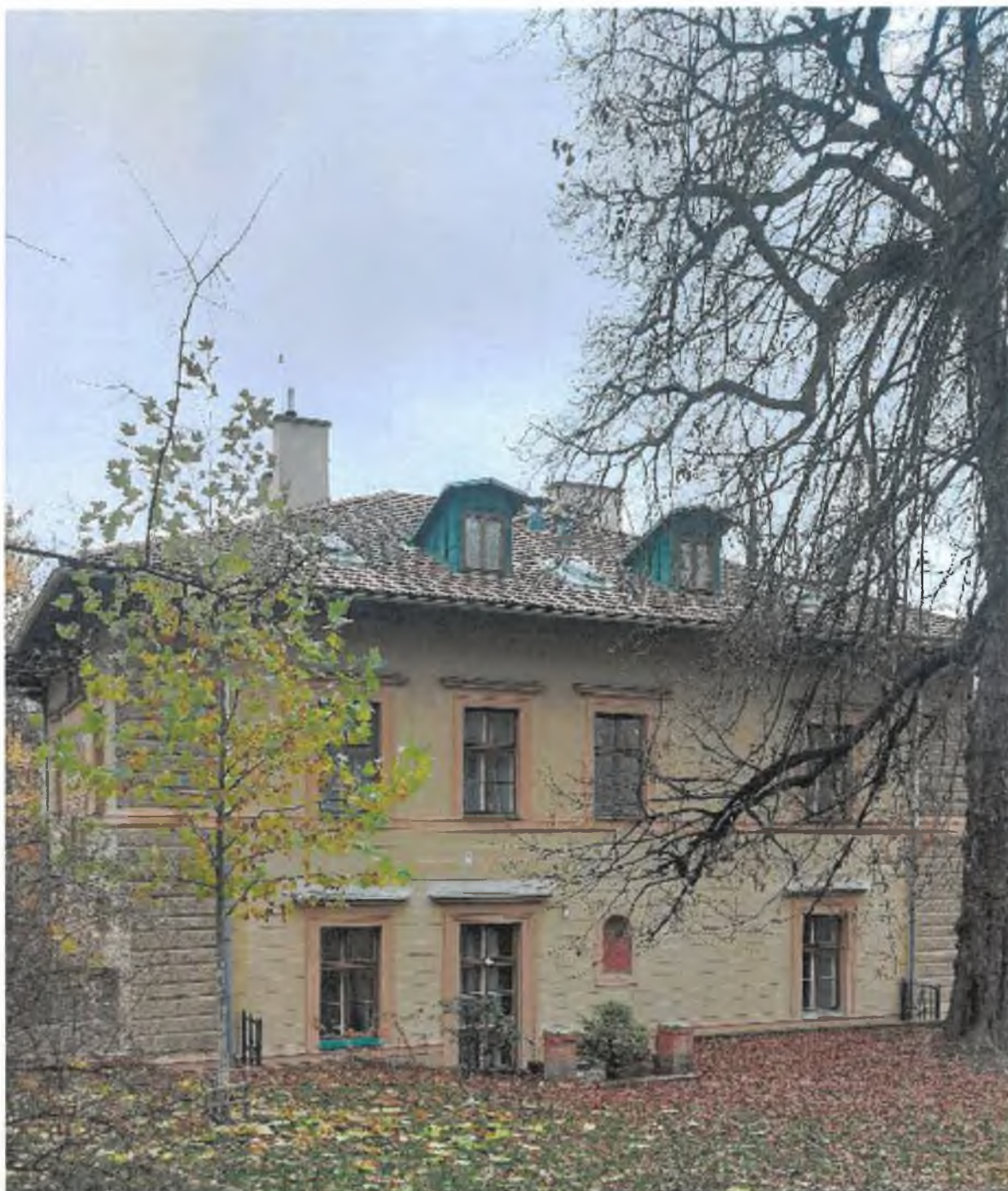
Foto 4 – Fasáda – severní fasáda
