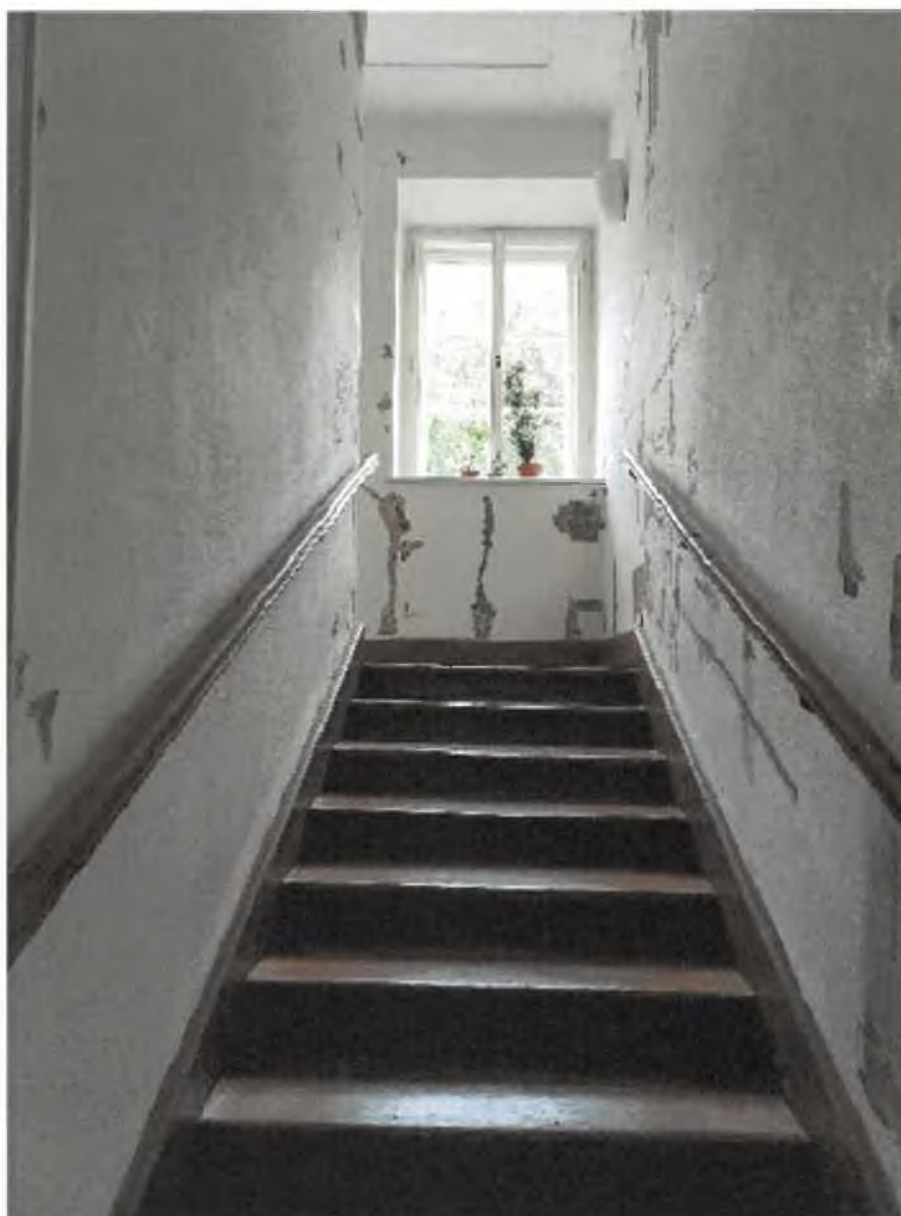
Foto 14 – Interiéry – hlavní schodiště dřevěné a viditelné zásahy pro prováděný stratigrafický průzkum malířských vrstev
