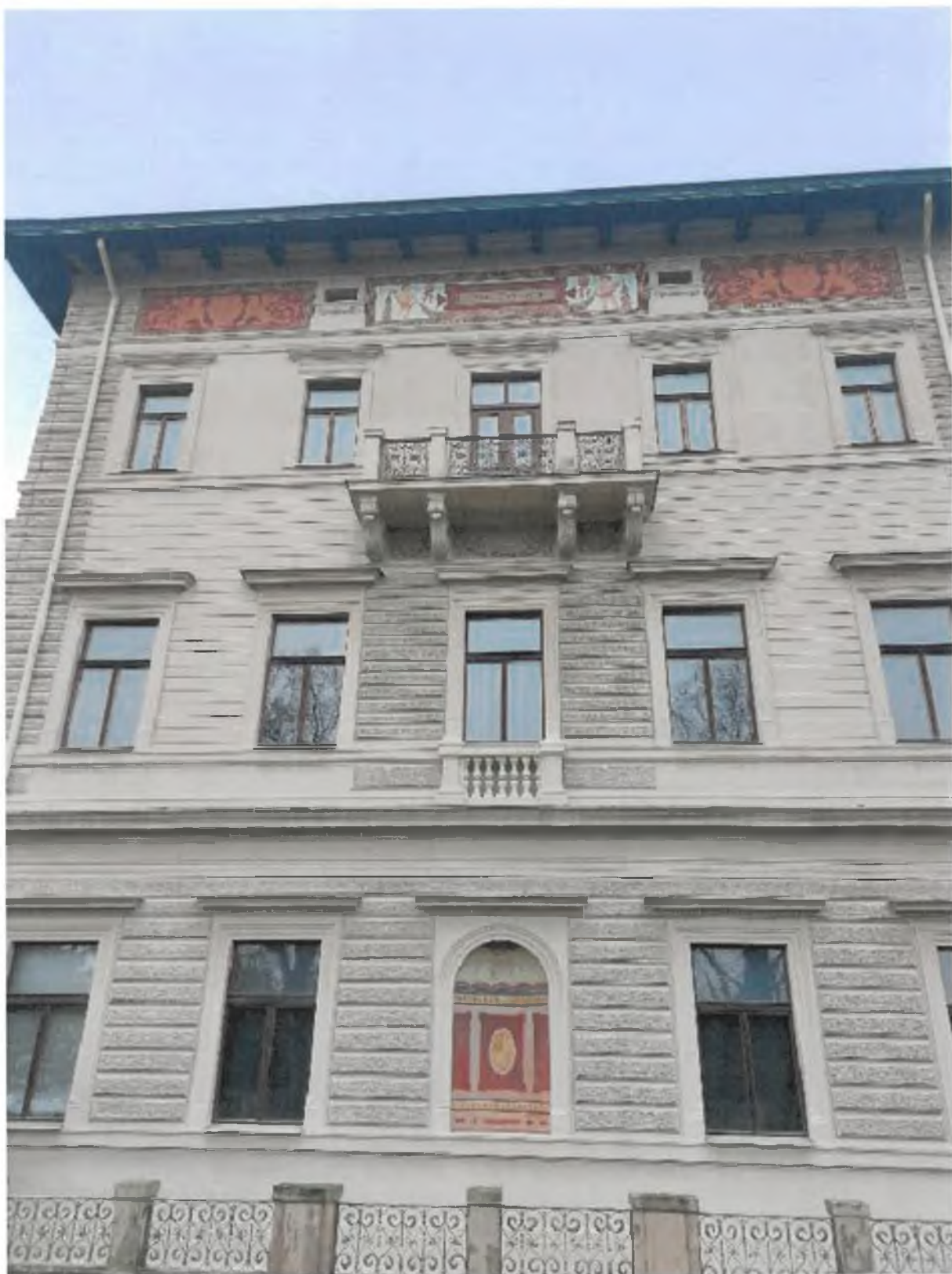
Foto 6 – Fasáda – východní fasáda
