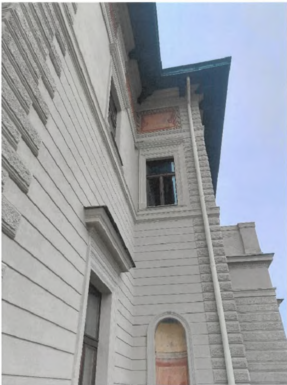
Foto 8 – Fasáda – jižní fasáda
