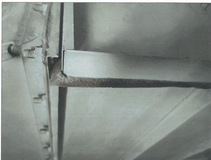
Obrázek 10: Těsnění vzduchotechniky, použit molitan, případně pryž
