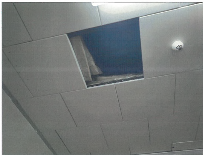
Obrázek 9: Lakovaná plechová konstrukce podhledu s tepelně izolační minerální vatou v igelitu
