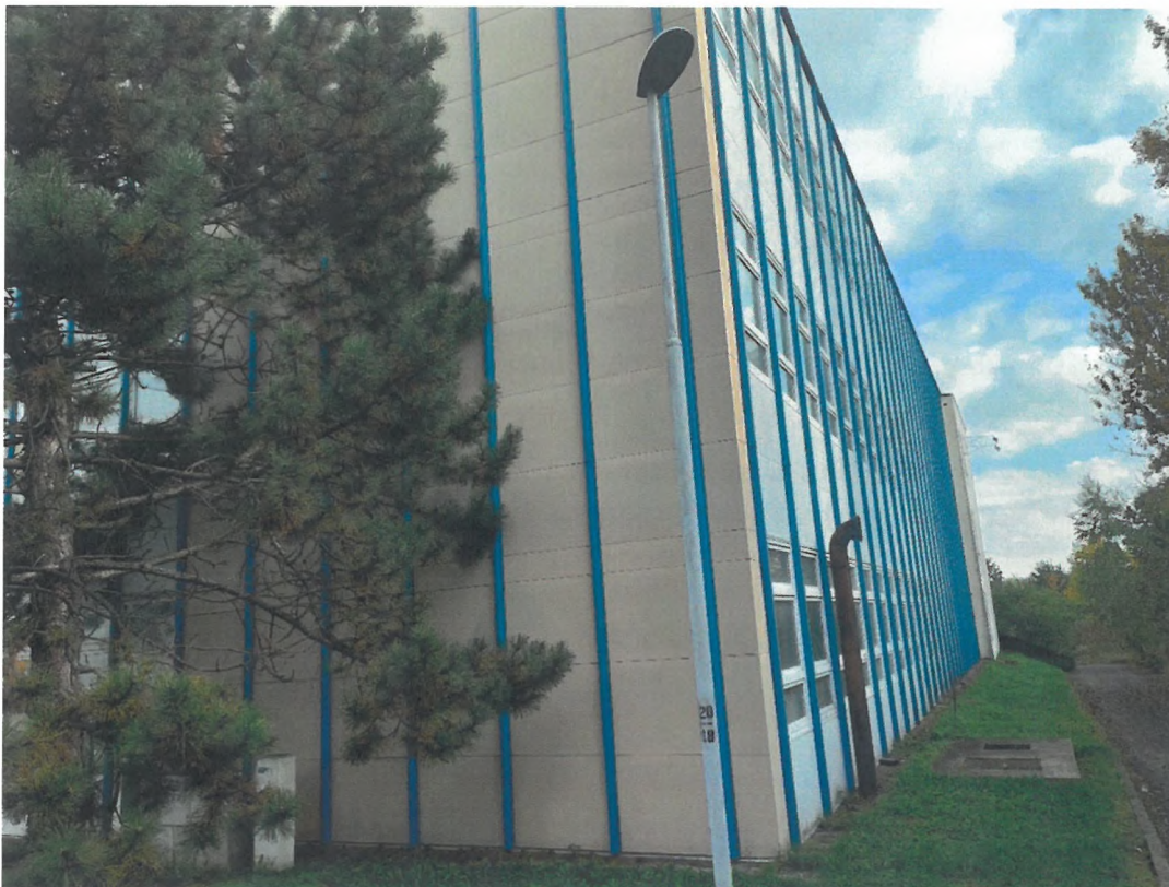
Obrázek 2: Pohled na montovanou část objektu z ulice K letišti
