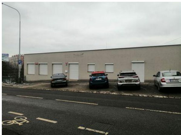
Pohled na budovu provozovny z ulice Moskevská
