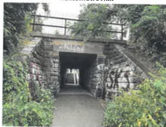
most ul. Na Spádu km 180,474
