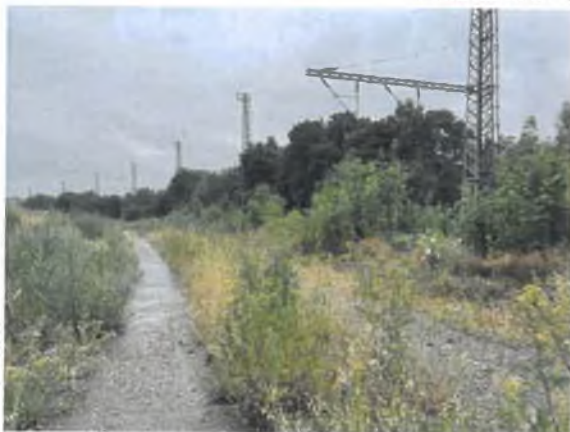
osvětlovací věže s výložníky
