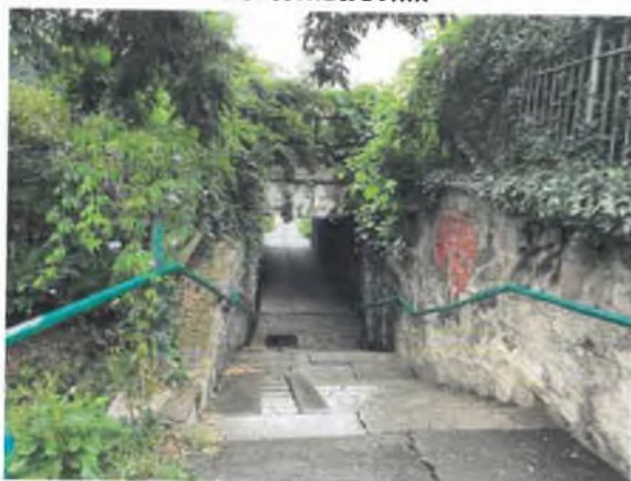
most ul. Na Spádu km 180,474
