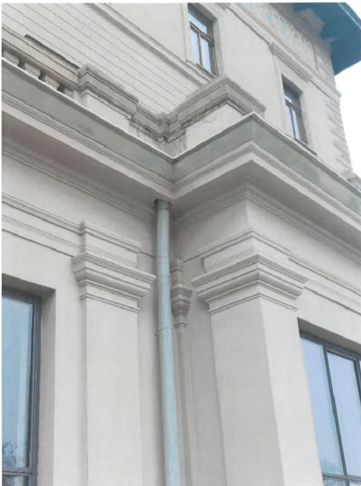
Foto 18 – Fasáda – západní fasáda – řešení dešťového odpadu
