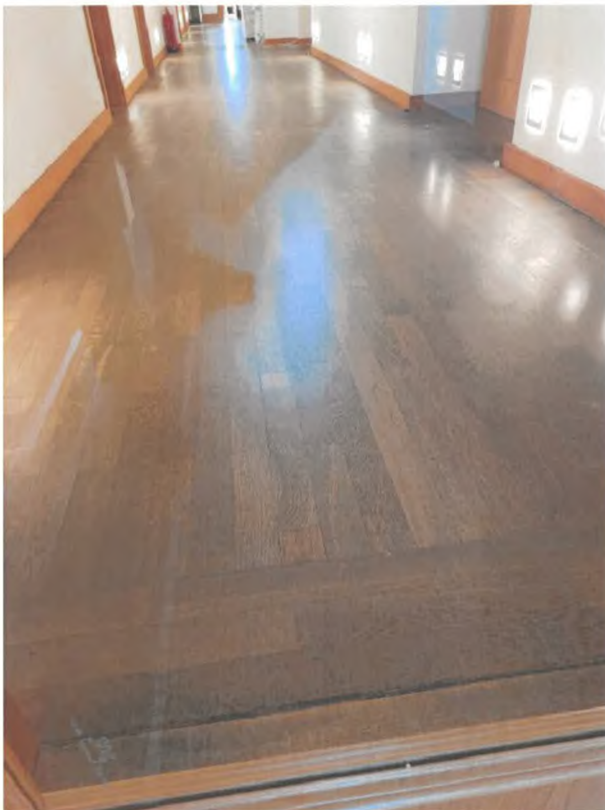
Foto 65 – Interiér – Kancelářská část – chodba – dřevěná podlaha v dobrém stavu
