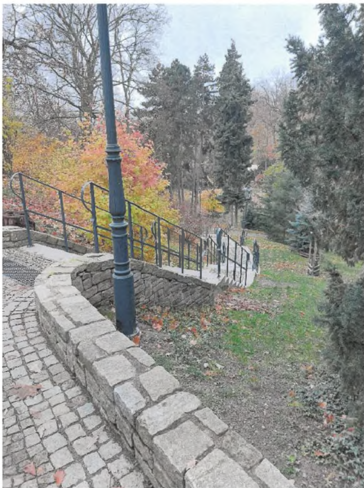
Foto 35 – Venky – Parkové schodiště vyhovující
