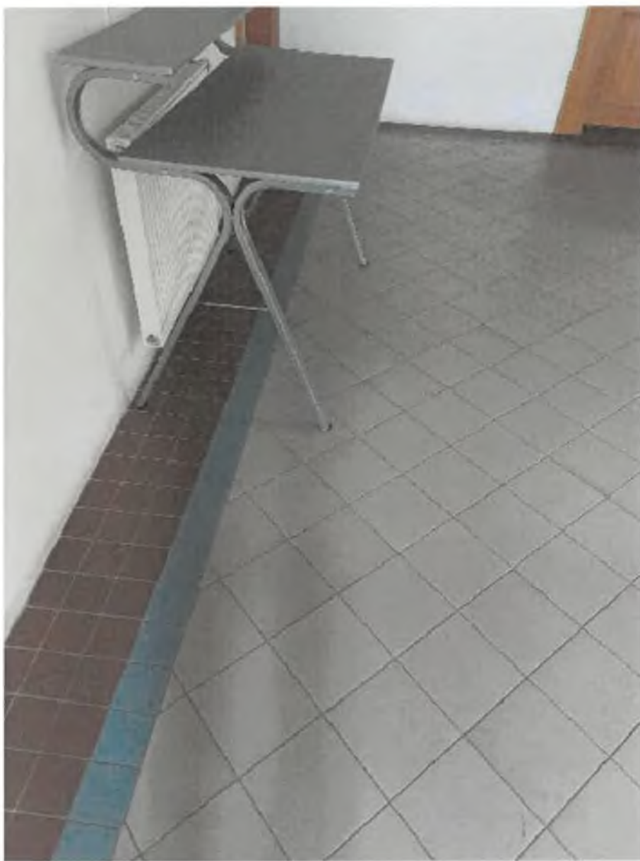
Foto 11 – Interiéry – dlažba ve vstupní chodbě
