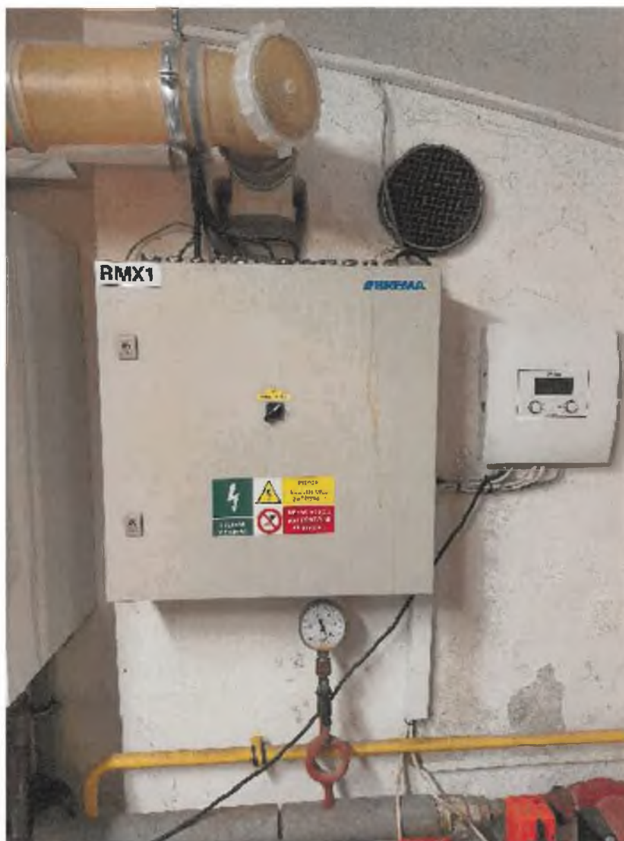
Foto 28 – Interiéry – technická místnost – elektrorozvaděč + odkouření
