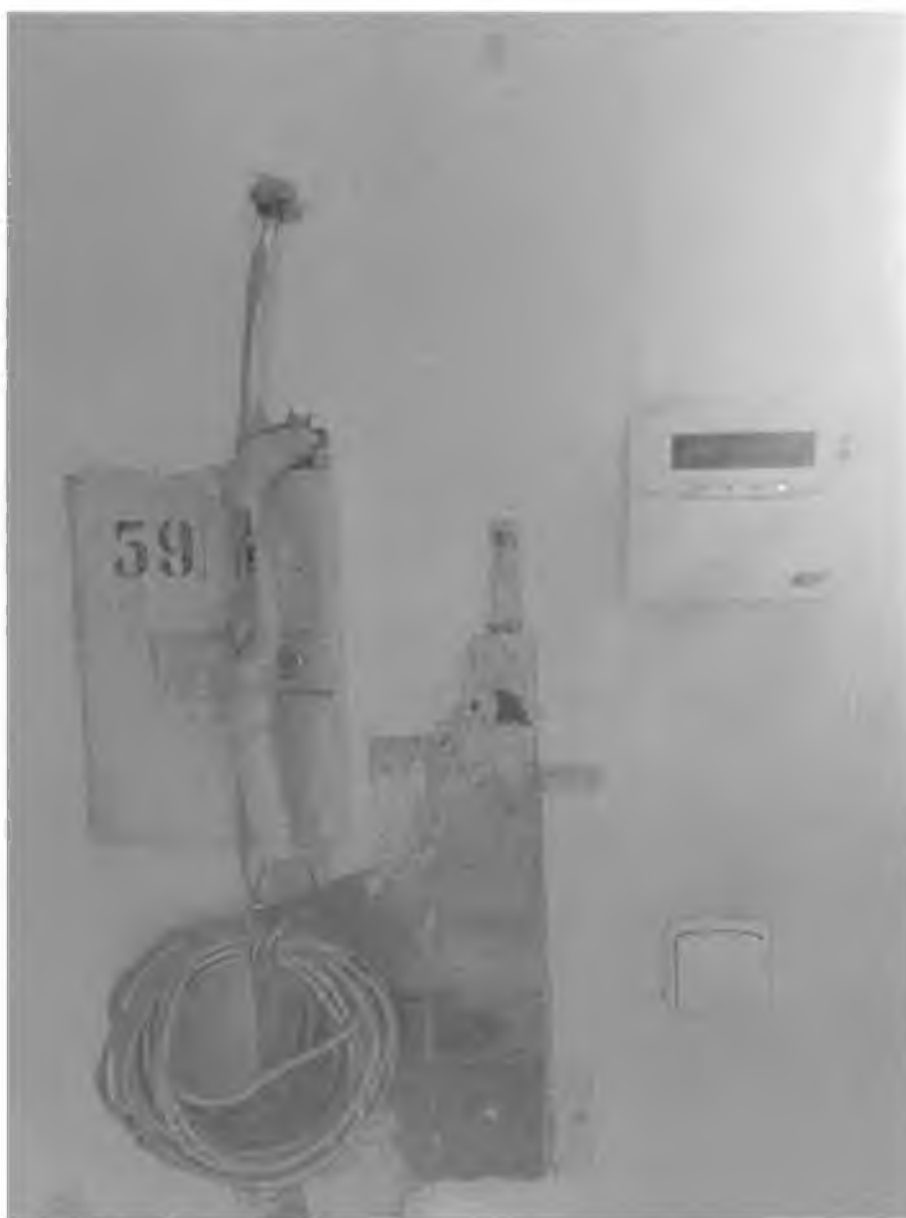
Foto 13 – Interiéry – stratigrafický průzkum malířských vrstev na chodbě
