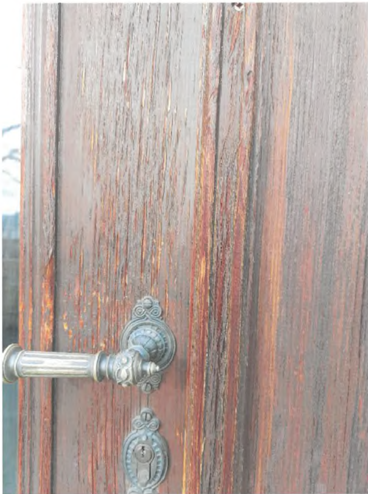
Foto 26 – Výplně otvorů – postupná degradace dveří
