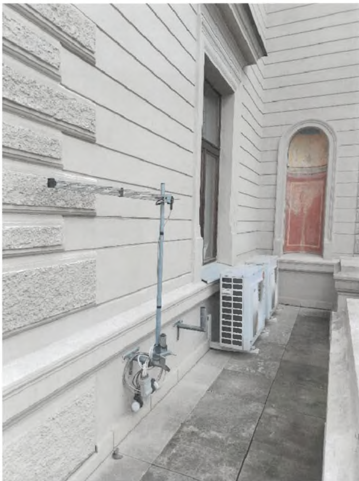
Foto 7 – Fasáda – jižní terasa
