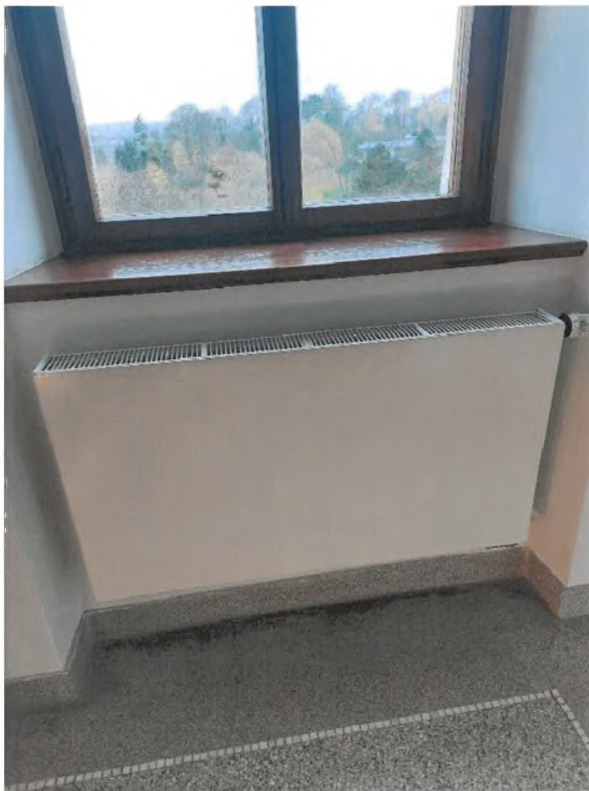
Foto 62 – Interiér – Stav otopných těles - vyhovující
