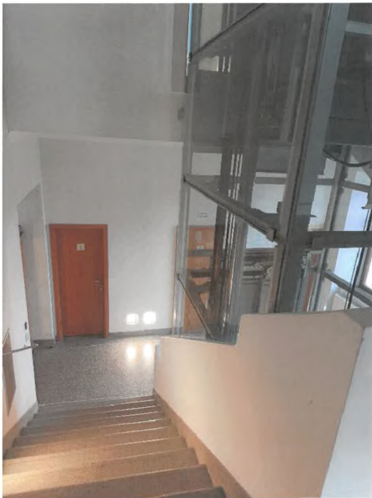
Foto 63 – Interiér – Interiérové povrchy a výtah vyhovující
