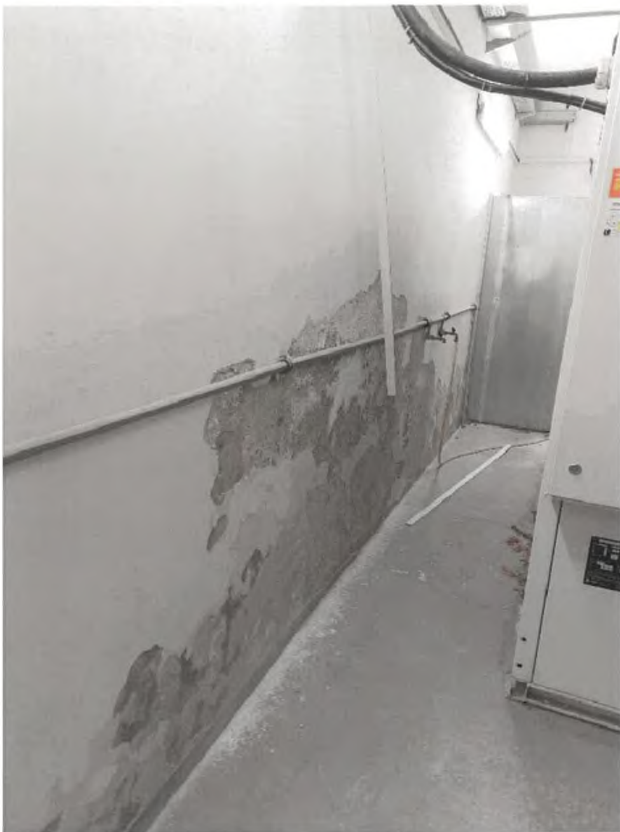
Foto 70 – Interiér – Vlhké sklepy – doporučeno řešit větrání + Chladicí jednotka (chiller) TRANE 3-D Scroll, určená k výrobě chladu pro vodní okruh (např. fan coils, VZT chladiče, klimatizaci serverovny nebo objektu)
