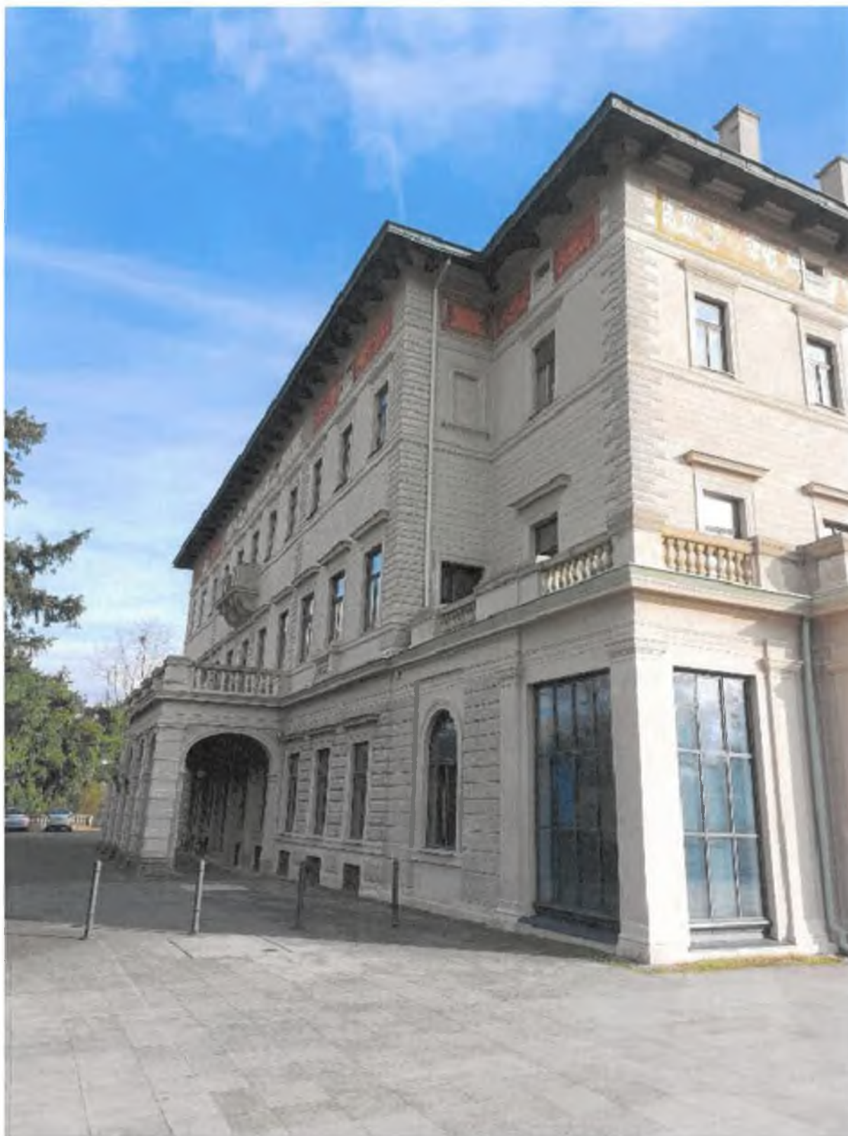
Foto 3 – Fasáda – severozápadní roh
