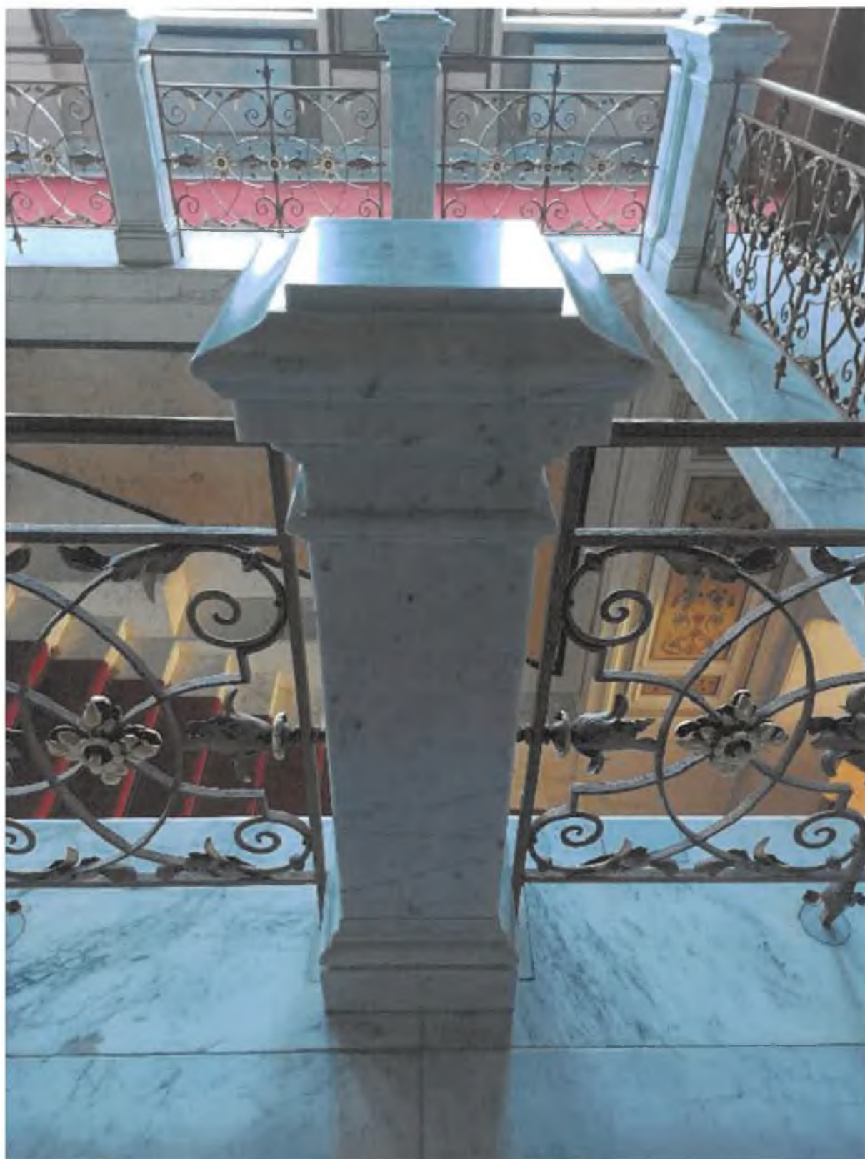
Foto 53 – Interiér – Reprezentativní mramorové a kovové prvky na hlavním schodišti
