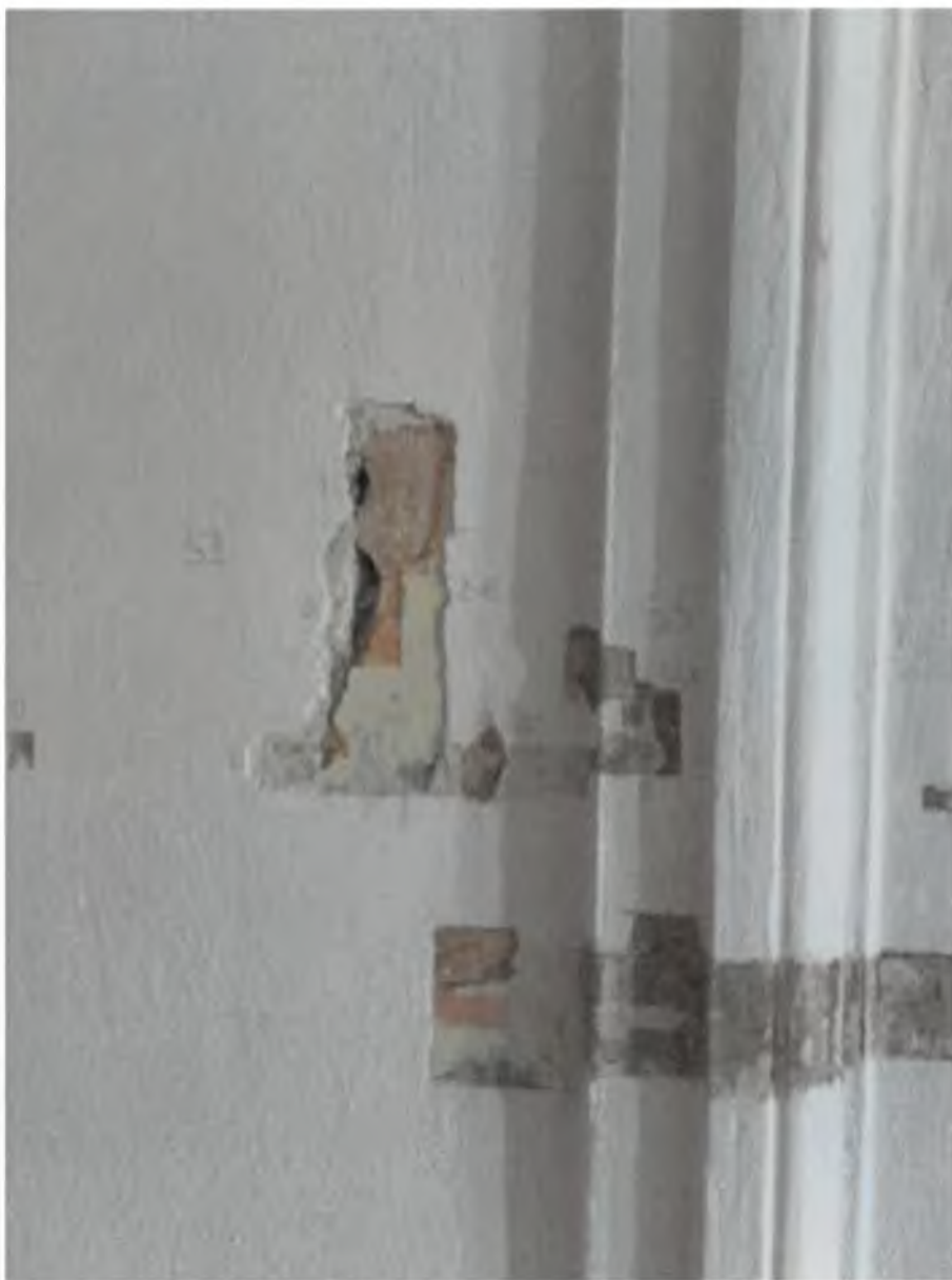
Foto 9 – Interiéry - stratigrafický průzkum malířských vrstev na chodbě
