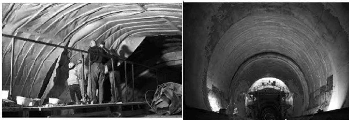
Obr. 4 Instalace energetické rohože v testovacím úseku raženého tunelu Lainzer ve Vídni
