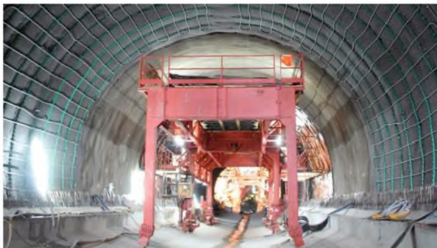
Obr. 17 Instalace potrubí pro získání geotermální energie v konvenčně raženém v tunelu Fassenhof
