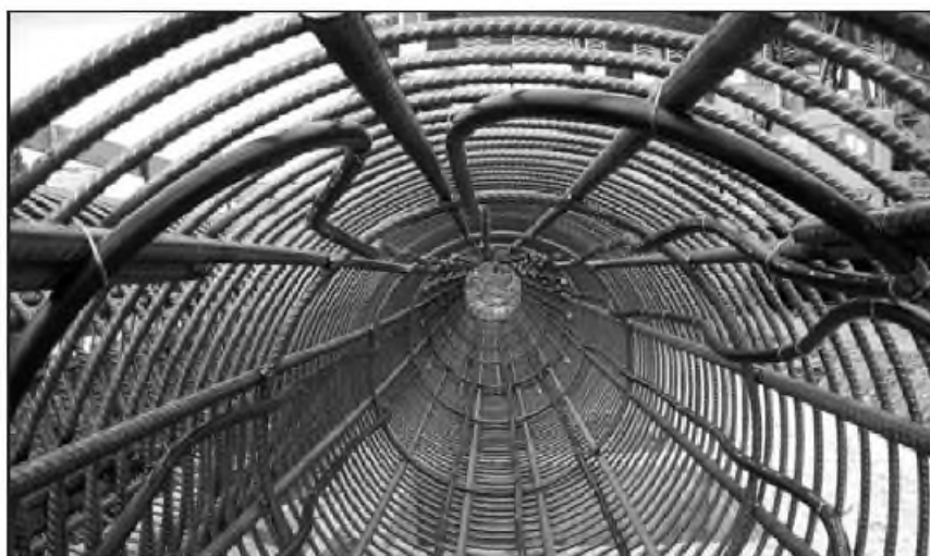
Obr. 10 Příklad upevnění absorpčního okruhu k výztuži energetické piloty
