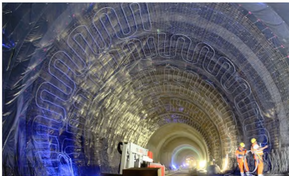
Obr. 14 Instalace hydraulických obvodů v tunelu Rosenstein
