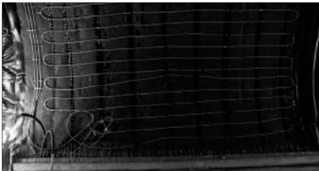
Obr. 5 Instalace energetické rohože ve zkušebním úseku tunelu Fasanenhof ve Stuttgartu
