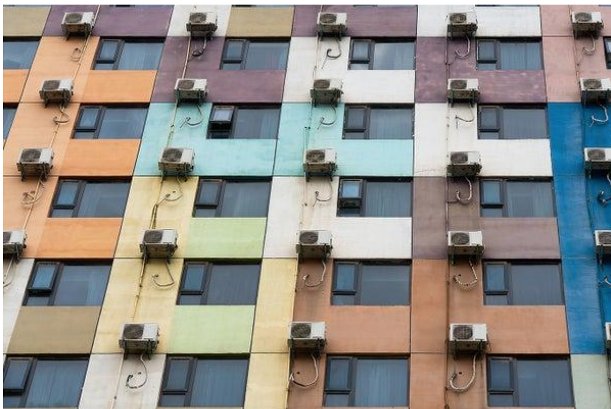
Obrázek 11: Ukázka venkovní fasády budovy s venkovními jednotkami
