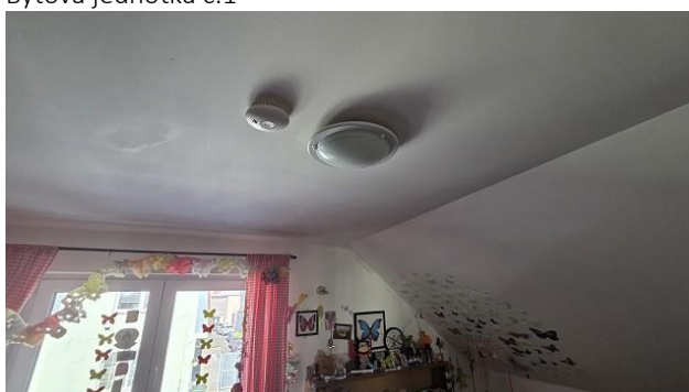
Bytová jednotka č.1
