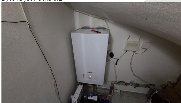
Bytová jednotka č.1
