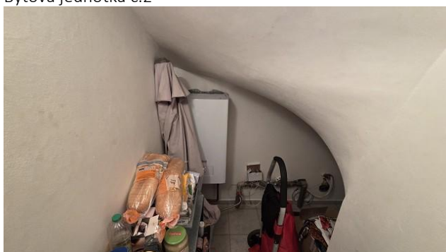
Bytová jednotka č.2
