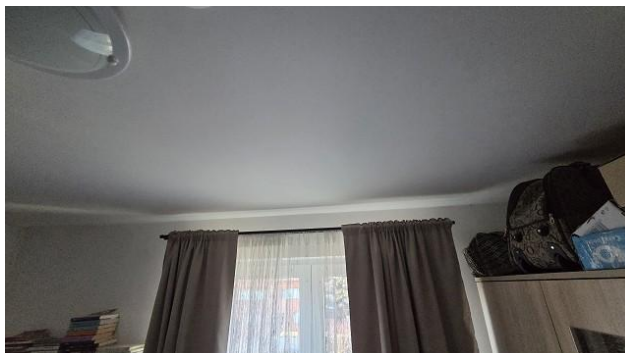
Bytová jednotka č.1
