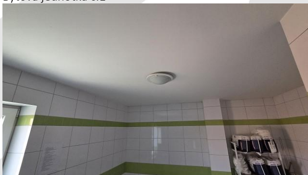
Bytová jednotka č.1
